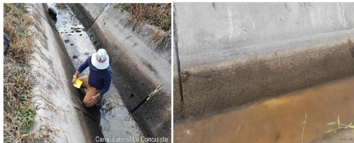
Foto: Juntas Elastómeras deterioradas e inexistentes
