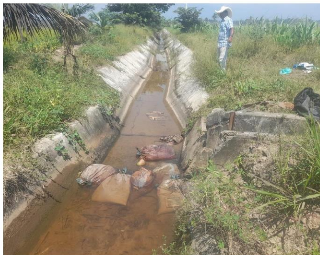
Foto: Progresiva 2+218, muros laterales deteriorados, con filtración de agua a talud de relleno.
