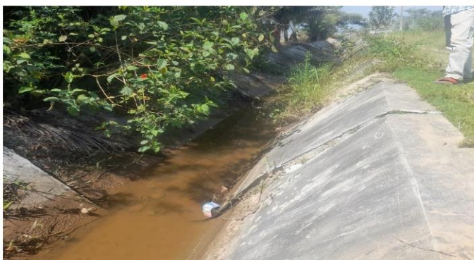
Foto: Empuje y rotura Progresiva 1+980
