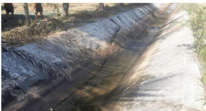
Foto: Empuje y rotura Progresiva 2+000
