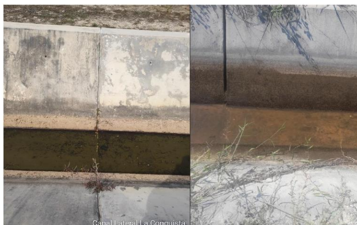
Foto: Juntas Elastómeras deterioradas e inexistentes
