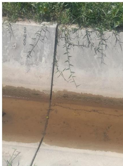
Foto: Juntas Elastómeras inexistentes
