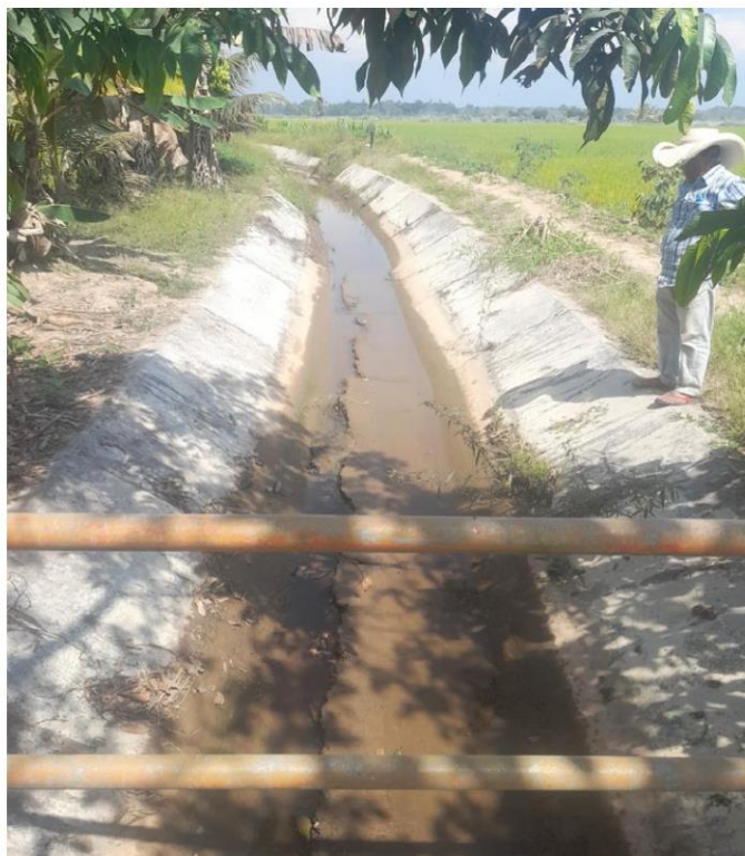
Foto: Asentamiento y rotura Progresiva 2+120 – 2+140
