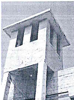
Vista de la parte exterior de los torreones, con desgaste y desprendimiento de pintura, a realizar mantenimiento preventivo.
