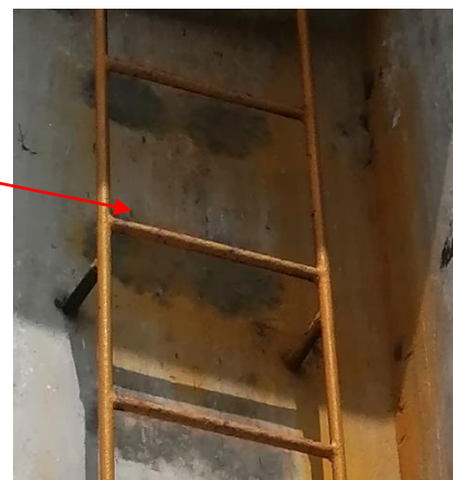
Escalera metálica a desmontar Estructura corroída
