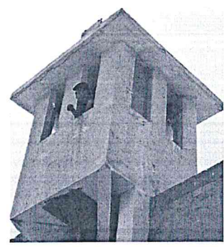
Vista de la parte exterior de los torreones, con desgaste y desprendimiento de pintura, a realizar mantenimiento preventivo.
