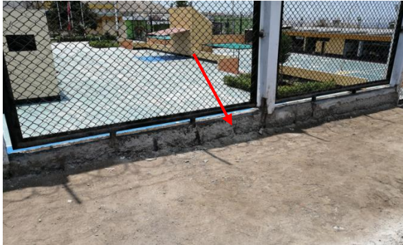
Vista de la base de concreto considerado para su reparación en el interior del EP.
