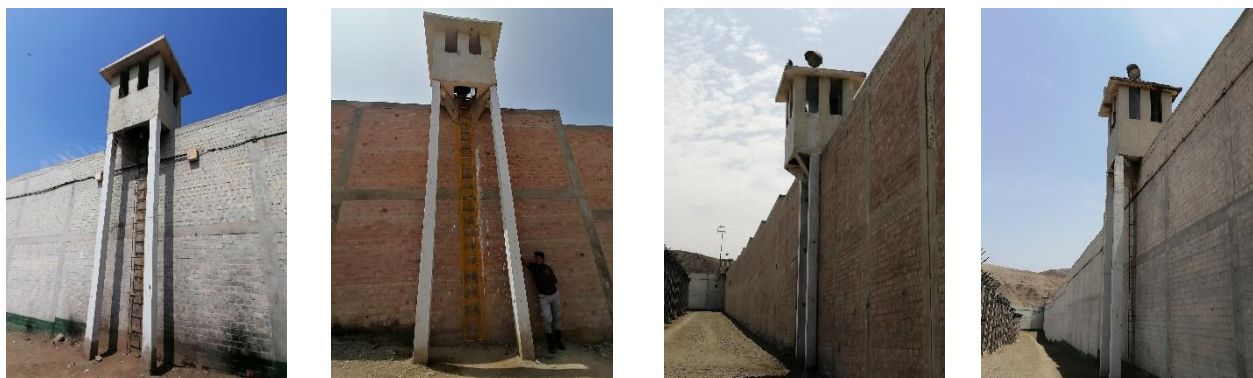
Vista de las columnas en exterior de torreones, con desgaste y desprendimiento de pintura.
