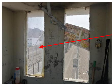
Vidrios con Presencia de rajaduras
