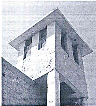
Vista de la parte exterior de los torreones, con desgaste y desprendimiento de pintura, a realizar mantenimiento preventivo.
