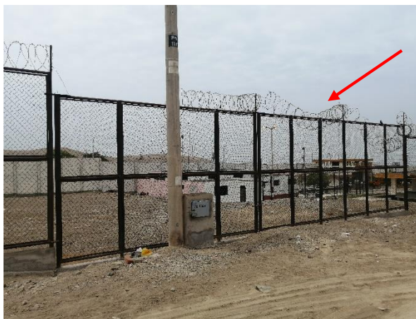
Vista de las concertinas a desmontar ubicado en la parte alta del cerco metálico.
