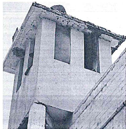
Vista del interior y alero de los techos de torreones, con presencia de fisura, grieta, cajoneo de tarrajeo y desprendimiento de concreto en friso.
