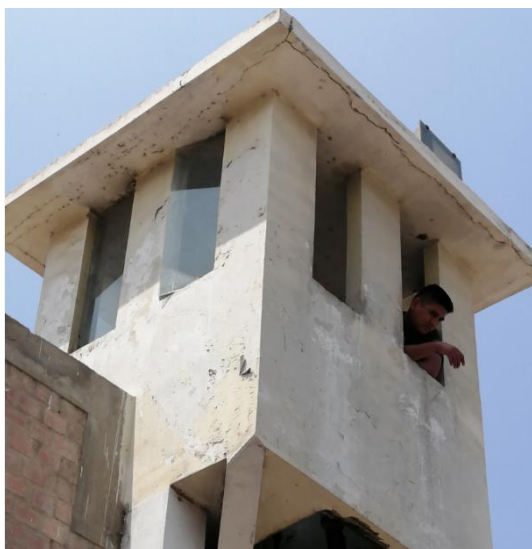
Vista del interior y alero de los techos de torreones, con presencia de fisura, grieta, cajoneo de tarrajeo y desprendimiento de concreto en friso.
