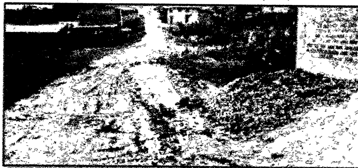
Foto N° 2: Vista de la Ca. Miraflores, podemos observar que la vía no está pavimentada y en época de lluvia se forman charcos, lo que dificulta el tránsito de vehículos. Se aprecia que no hay veredas existentes.
