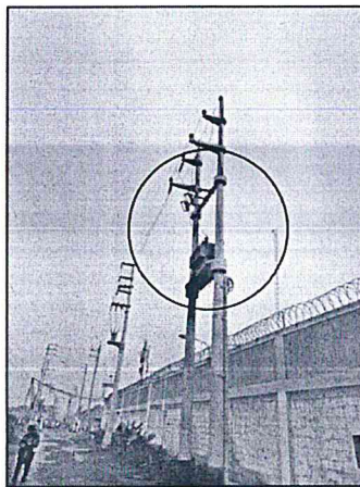
Imagen 5. Tramo de conductor Cu 25mm2 a reemplazar
