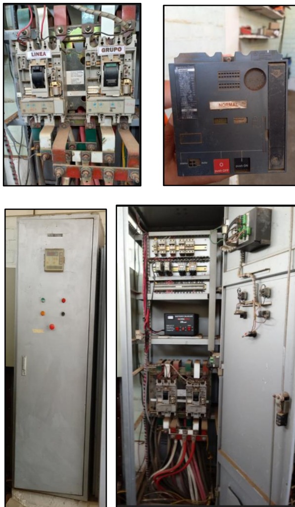
Imagen 7. Tablero de transferencia automática (TTA)
