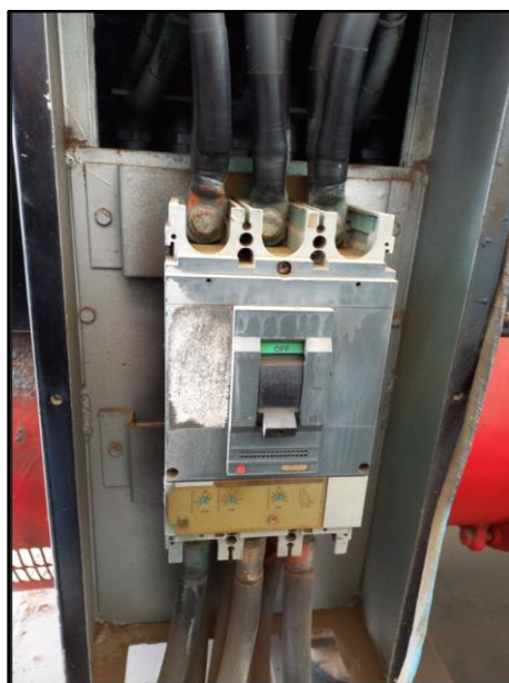
Imagen 10. Interruptor principal del grupo electrógeno 275kW
