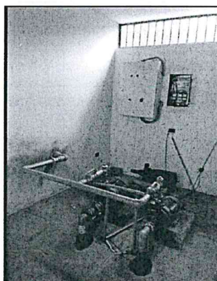
Imagen 13. Electrobombas de 11HP
