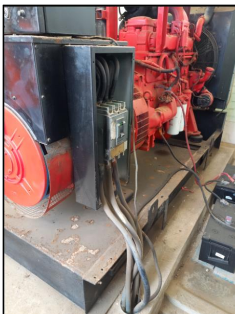
Imagen 10. Interruptor principal del grupo electrógeno 275kW
