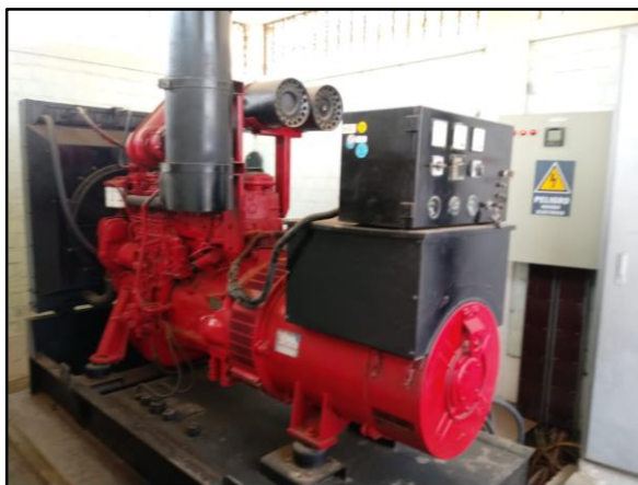
Imagen 9. Grupo electrógeno 275kW
