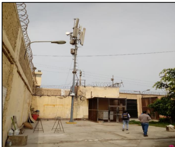
Imagen 19. Luminaria Na 250W en pastoral de pared perimetral
