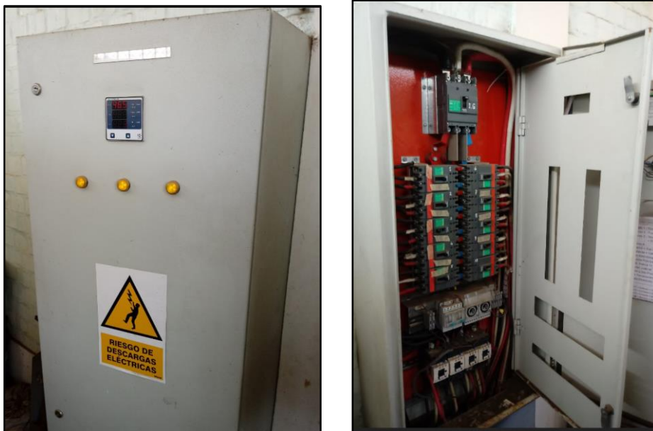
Imagen 8. Tablero de emergencia adosado
