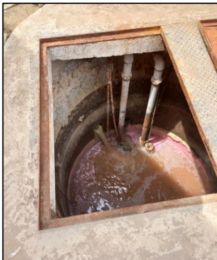
Imagen 17. Electrobomba sumergible de 4.5HP
