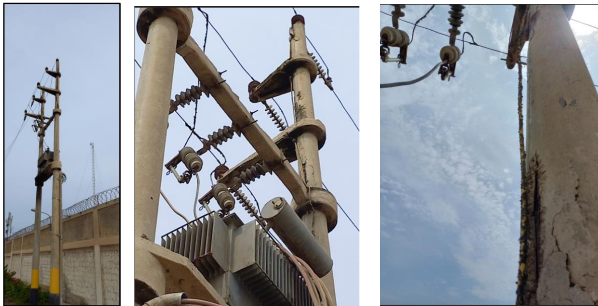
Imagen 2. Subestación aérea biposte existente (SAB)
