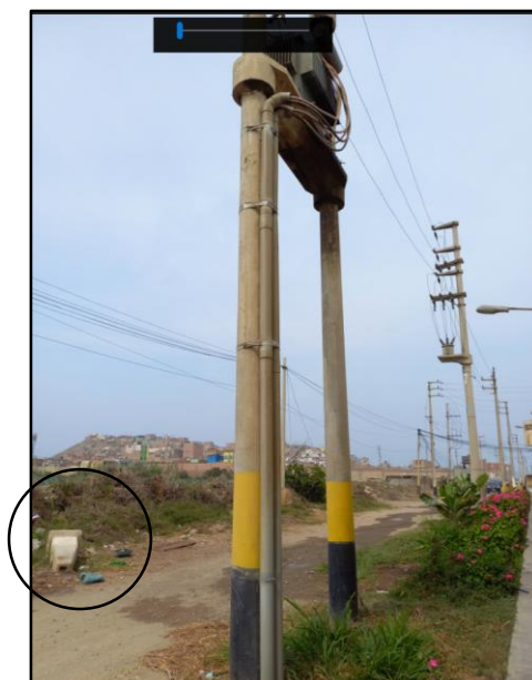
Imagen 3. Bloque de protección contra impacto existente a instalar a pie de la nueva SAB
