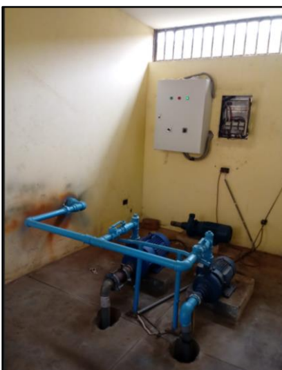
Imagen 13. Electrobombas de 11HP
