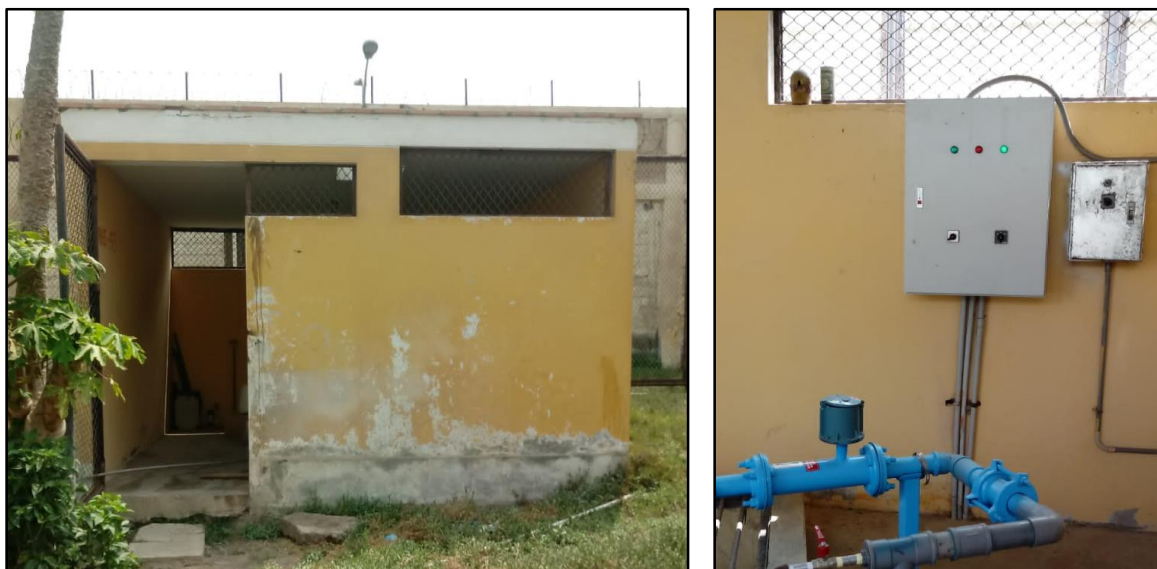
Imagen 14. Tablero de fuerza y control de electrobombas de cloración
