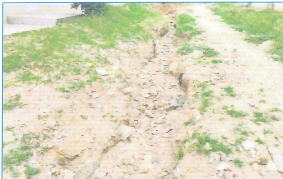
IMAGEN N° 02: CALLE TOTALMENTE DETERIORADA POR LAS CONSTANTES PRECIPITACIONES PLUVIALES QUE SE VIENEN PRESENTANDO
