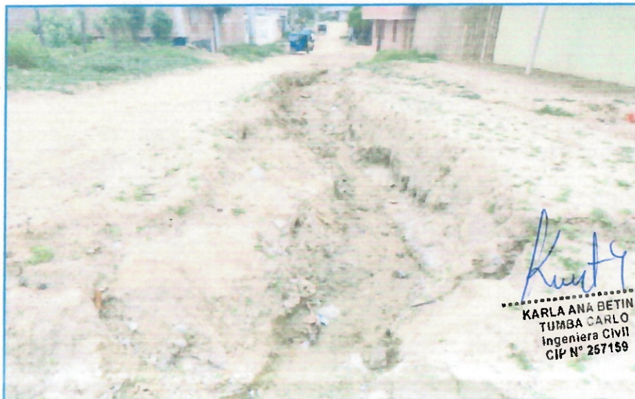
IMAGEN N° 03: EVIDENCIA DE TRAMO CRÍTICO DE LA CALLE EPICÉNACA, DESTRUIDA POR LAS INTENSAS Y CONSTANTES LLUVIAS
