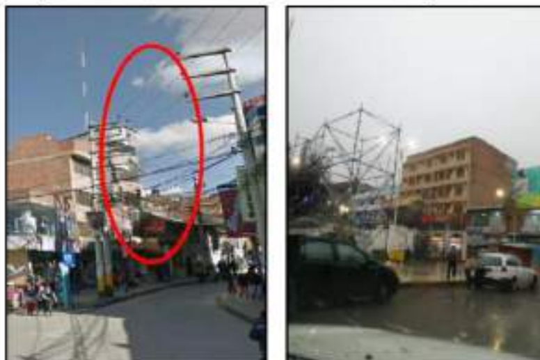
Fig. N° 06: Incumplimiento de las distancias mínimas de seguridad
