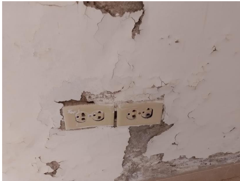
FOTO N°04: CHAPA DE LAS PUESTAS EN MAL ESTADO
