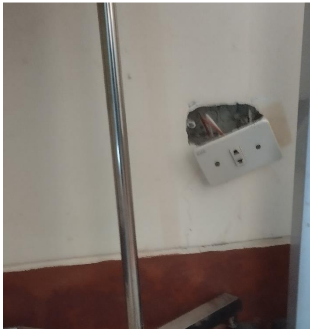
FOTO N°04: TOMACORRIENTES EN MAL ESTADO
