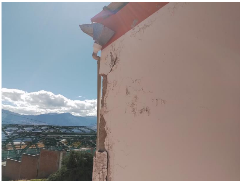
FOTO N°08: CANALETAS DETERIORADAS
