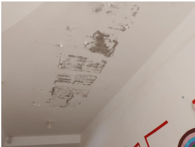
FOTO N°10 : PINTURA DE MUROS DETERIORADAS
