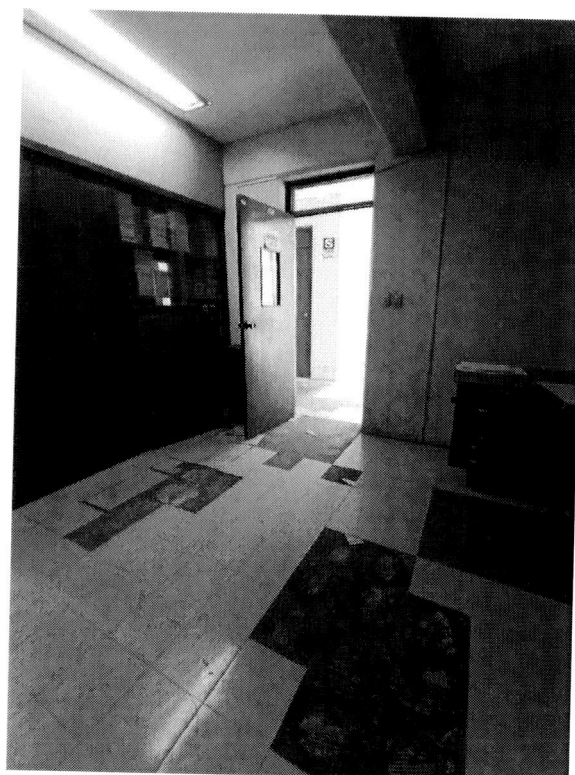
Pisos despegados por la antigüedad, retazos de carpintería de madera
