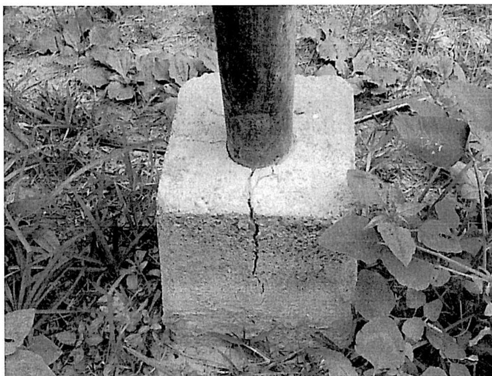
BASE DE CONCRETO DE FARO EN DETERIORADO
