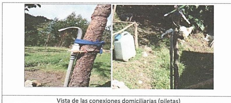
Vista de las conexiones domiciliarias (piletas)
