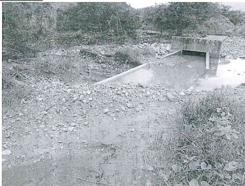
Tramo crítico colmatado del Canal El Mirador – Chongoyape
