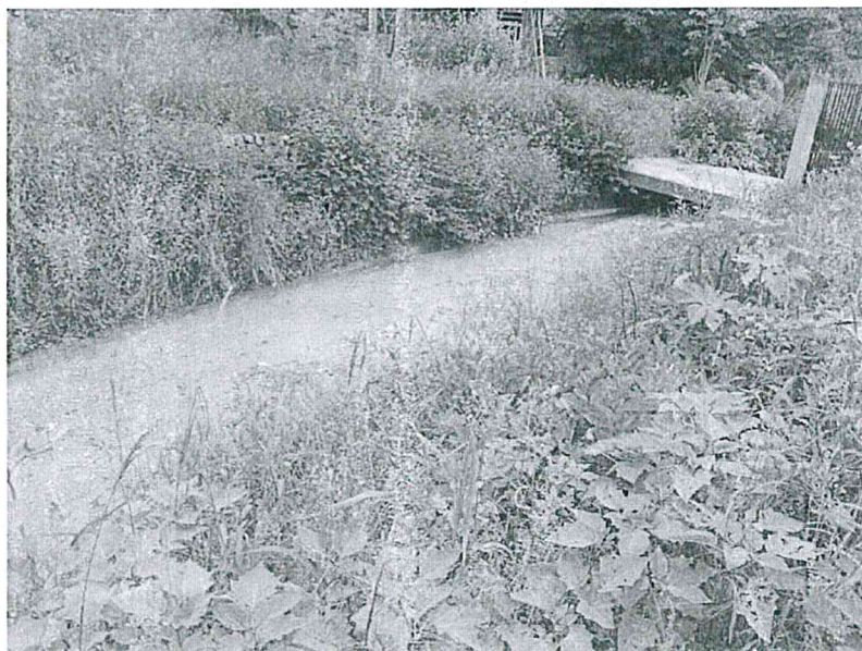
Tramo crítico colmatado del Canal Majin Paredones - Chongoyape
