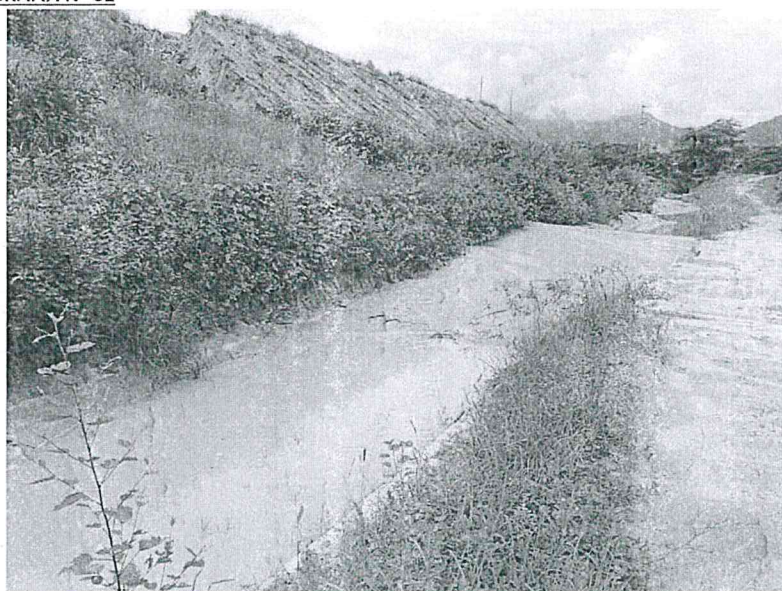
Verificación de colmatación de tramo crítico del Canal Majin Paredones - Chongoyape.
