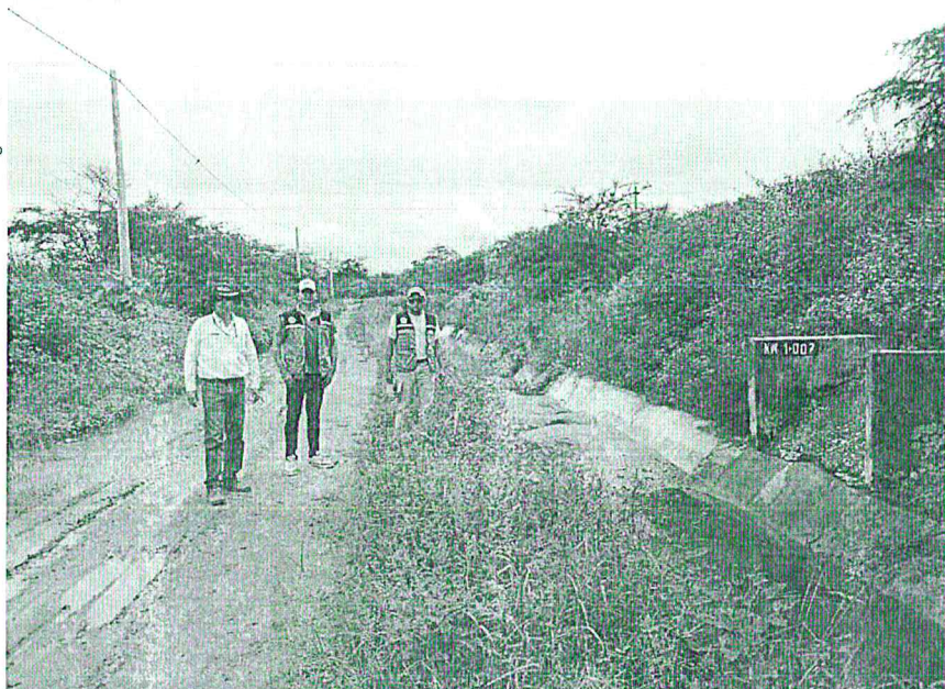
Material solido acumulado en el cauce del Canal Majin Paredones – Chongoyape
