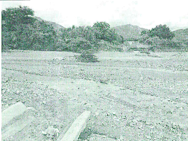
Colapso de canales de riego como consecuencia de erosión de taludes de Quebrada Chiriquipe
