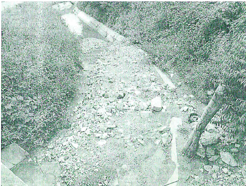
Material solido acumulado en el cauce del Canal Majin Paredones – Chongoyape
