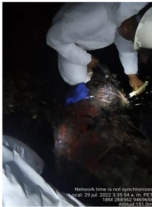
Fig. 2: Obturación de 06 cortes pasantes.
