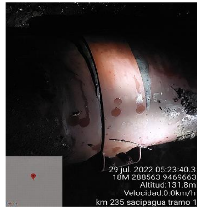
Fig. 3: Instalación de grapa emperrada.
