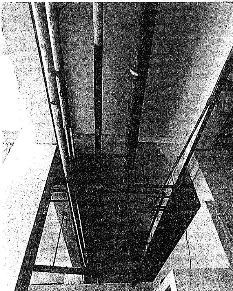
Registro fotográfico 4: Oxidación en las tuberías
