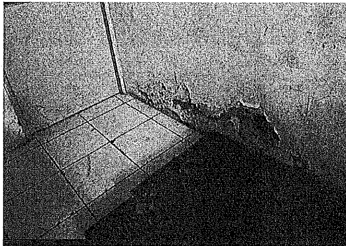
Registro fotográfico 5: Presencia de humedad en la base de muros
