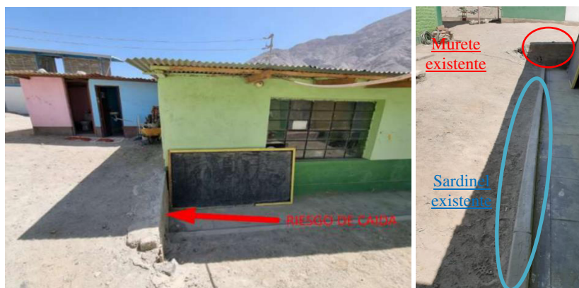
Imagen 13. Vista de sardinel y murete con riesgo de caída.
