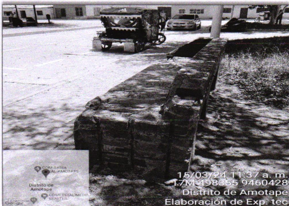
Fotografía N°03: Bancas existentes construidas de material de ladrillo, se encuentran en estado de deterioro, por lo que se propone su demolición.
