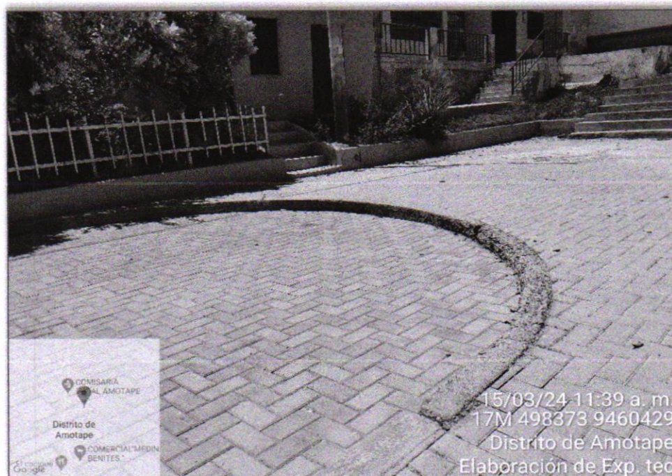
Fotografía N°02: Sardinell peraltado en estado de deterioro, por lo que se propone su demolición y reposición del mismo, según detalle de planos
