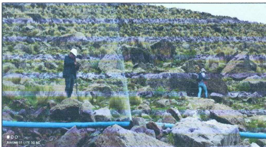
ILUSTRACIÓN 5: TUBERÍA DE LA LÍNEA DE CONDUCCIÓN EN MAL ESTADO
