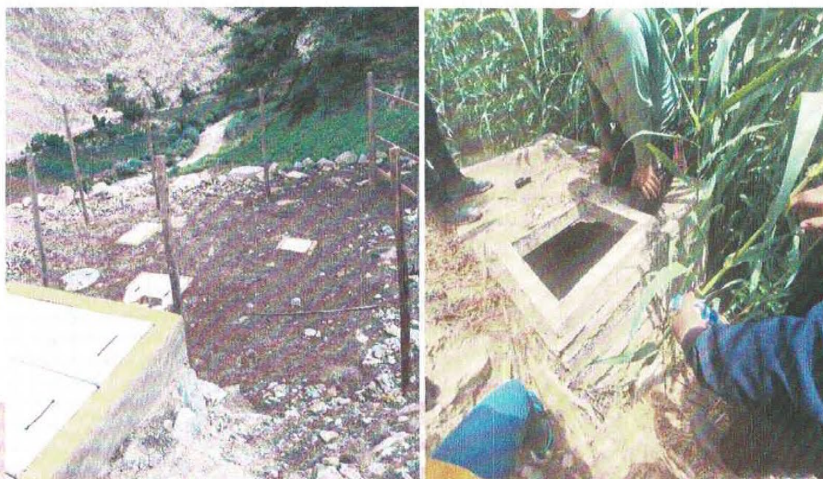
Captación de manantial en mal estado
