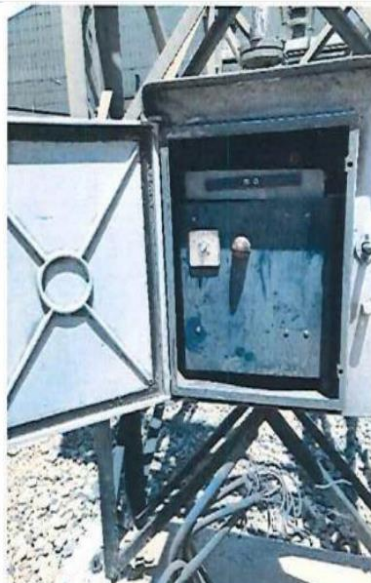
Fig. 5 Canalización y cable de control averiados
