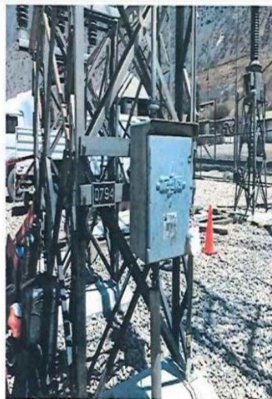
Fig. 6 Casi el íntegro del soporte está con inicios de corrosión.
