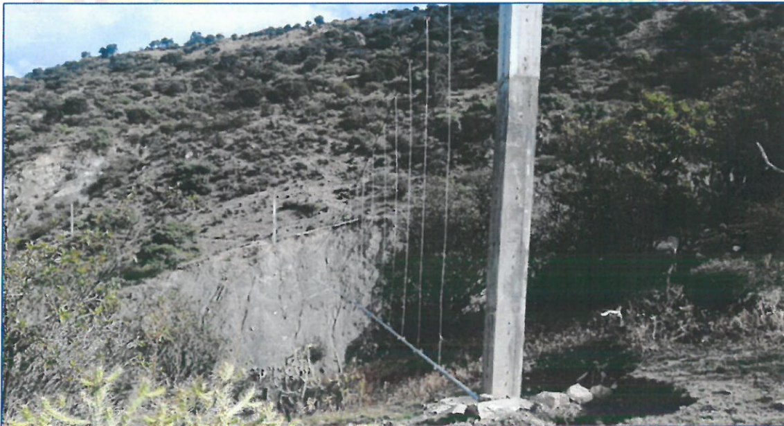
Imagen N° 2.20: Columna sin tarrajeo y pintura en cruce aéreo N° 01 existente sistema II localidad de Ccochancay.
