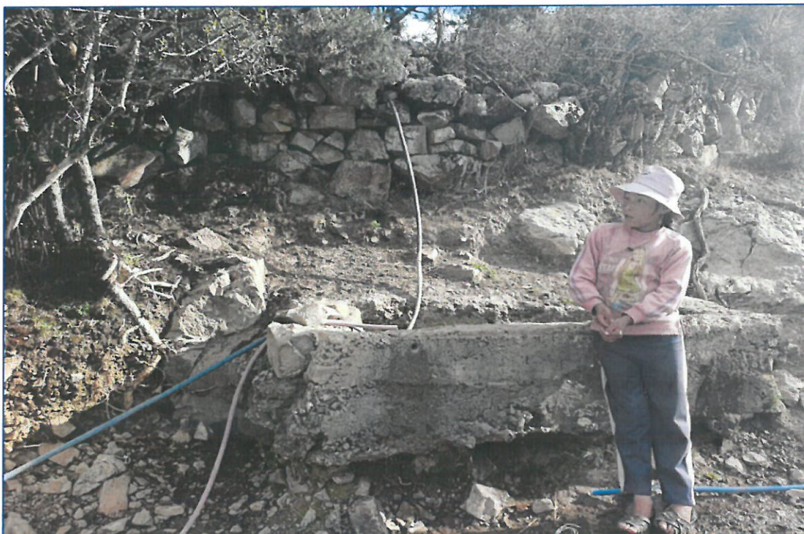
Imagen N° 2.34: Almacenamiento en una estructura inadecuada del sistema II localidad de Ccochanccay.
