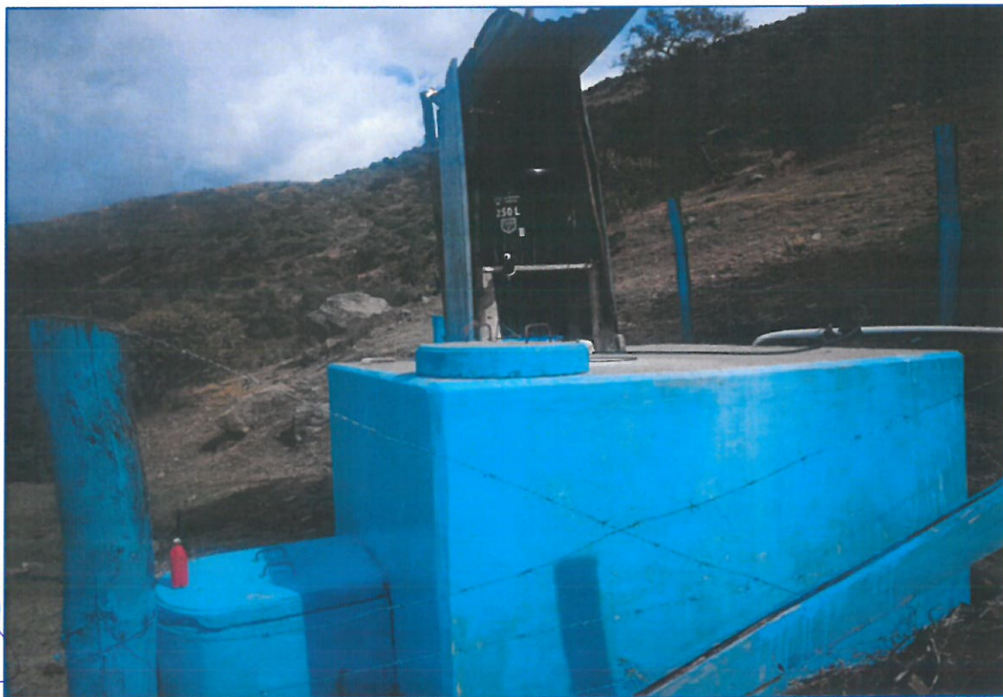
Imagen N° 2.27: Vista de la cloración en el reservorio existente V=5.0 m3 sistema I localidad de Ccochanccay.
