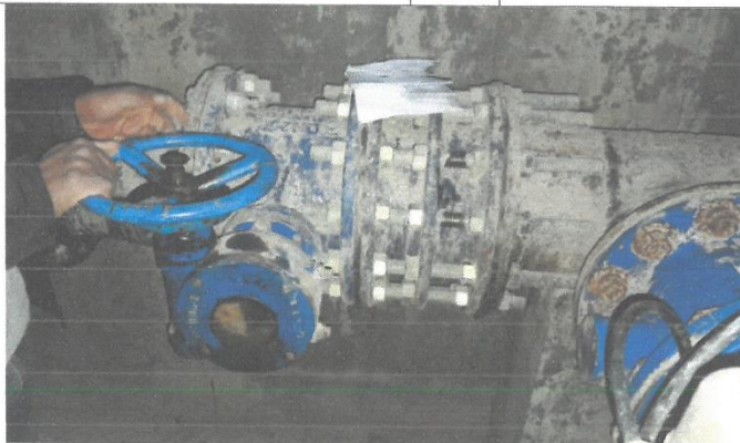
Fig N°20 Situación actual de válvulas reductora de presión, válvula compuerta tipo mariposa en CD: 01
