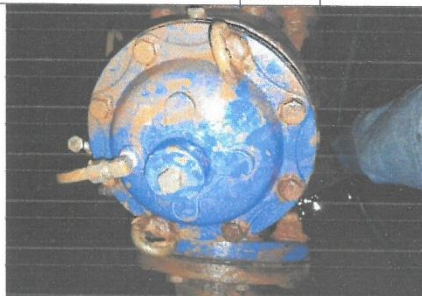
Fig N°12 Situación actual de válvulas reductora de presión en CRP: 12
