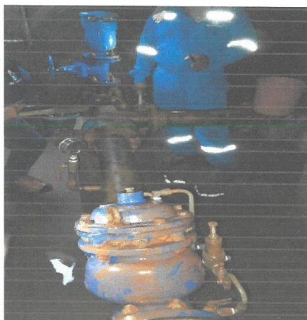
Fig N°6 Situación actual de válvulas reductora de presión, manómetros de aire y compuerta mariposa en CRP: 06
