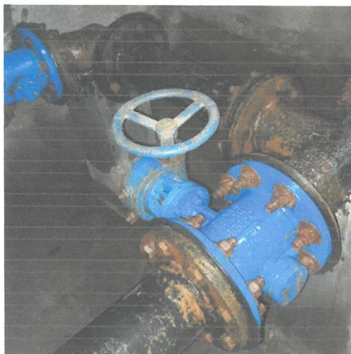
Fig N°7 Situación actual de válvulas reductora de presión, compuerta mariposa en CRP: 07
