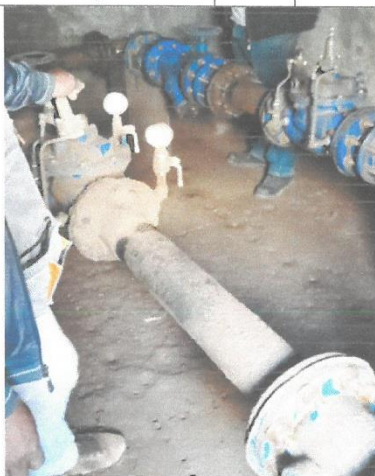
Fig N°9 Situación actual de válvulas reductora de presión, manómetros de aire y compuerta mariposa en CRP: 09
