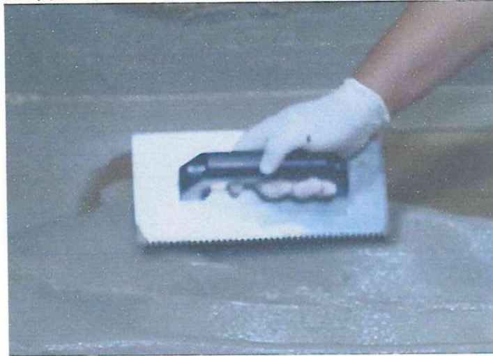
FIGURA 3: COLOCACION DE 1RA CAPA
