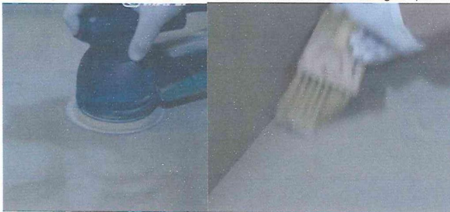
FIGURA 1: LIMPIEZA DE SUPERFICIES DE POLVO Y PARTICULAS
