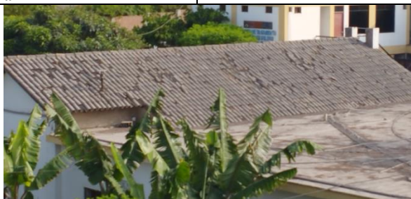
Foto N° 05. Teja en mal estado
