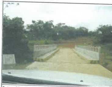
Foto 05: Puente de Concreto, en servicio. Con Plataforma, Veredas y Barandales en buen estado operativo.
