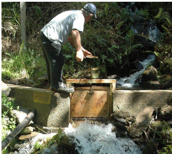
tomas laterales para la distribución del agua para riego en los diferentes parcelas.
