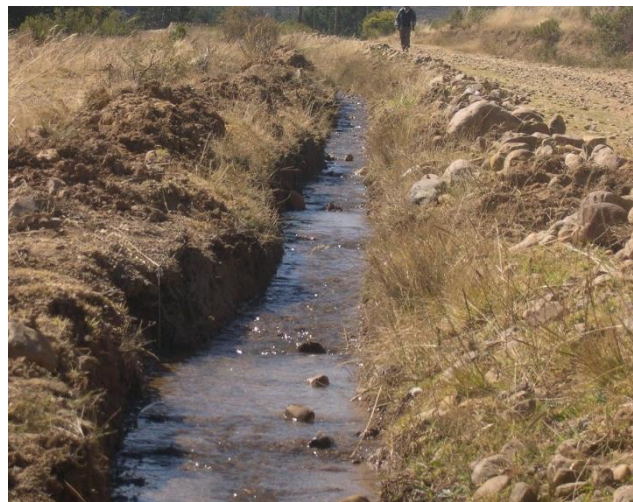
Canal labrado de manera rústica con un ancho de 55 cm y una profundidad de 45 cm y una conducción de 3.500km
