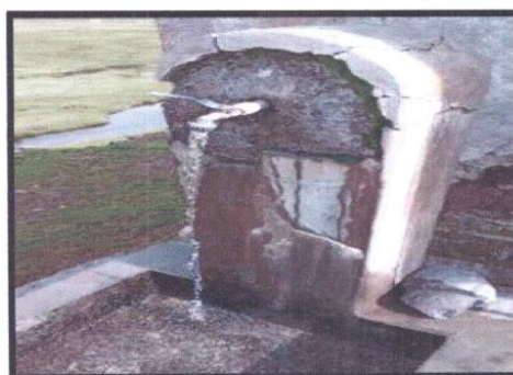
FOTOGRAFÍA N° 15 RESANE CON MORTERO EN PILETA
