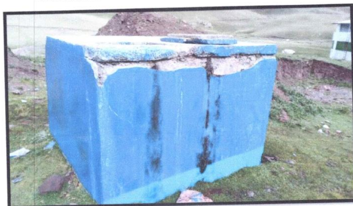
FOTOGRAFÍA N° 14 RESANE CON MORTERO EN RESERVORIO
