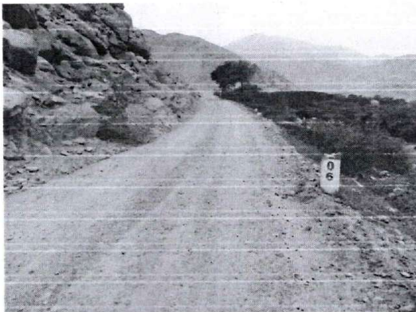
Foto N°03: Km 06 se aprecia la Calzada con material afirmado suelto.
