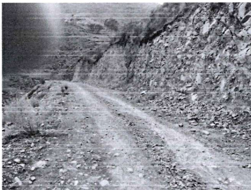
Foto N°08: km 88+240 se aprecia calzada y cunetas con material de derrumbes.
