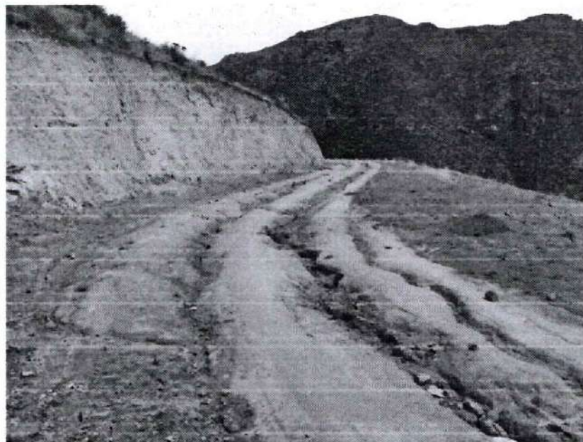
Foto N°06: Km 56+240 se aprecia el Surcos a causa de agua por lluvias intensas.
