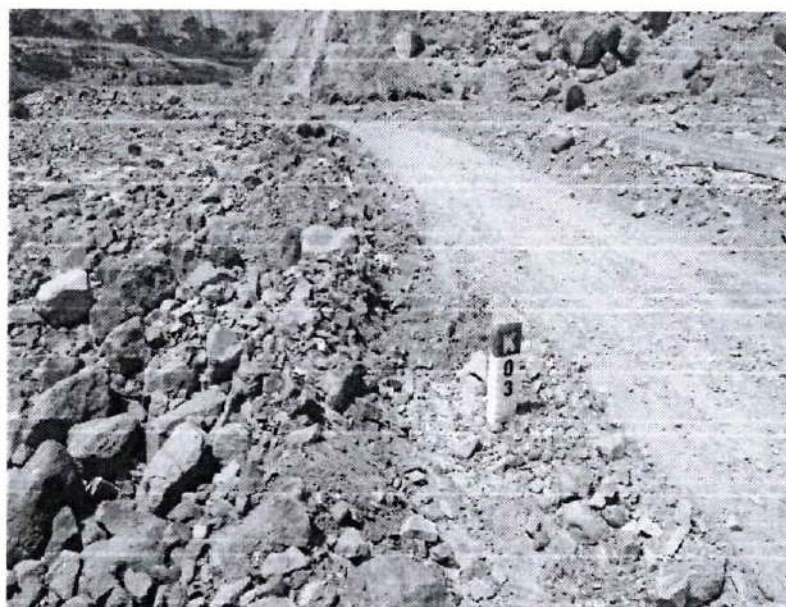
Foto N°02: Km. 03 se aprecia el afirmado disgregado en la vía.
