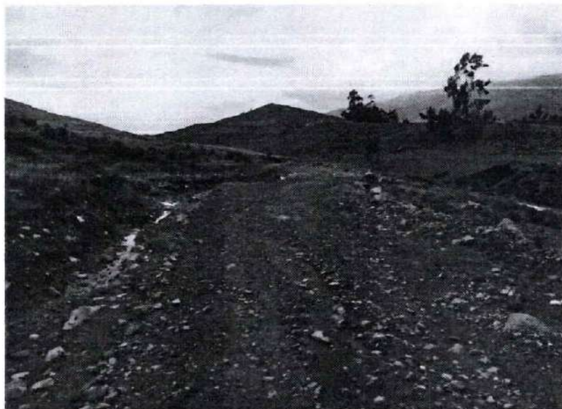
Foto N°09: Km 100+050 se aprecia la vía en mal estado debido a los cauces de agua producto de lluvias intensas.
