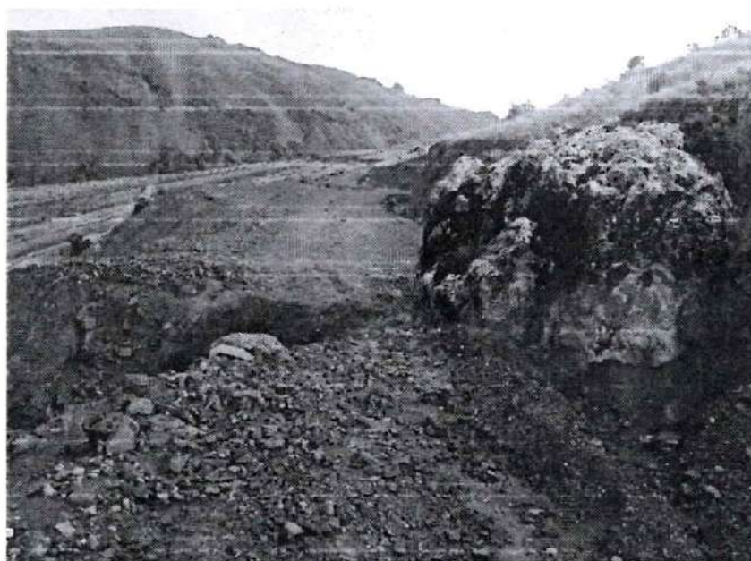
Foto N°10: Km 105+110 se puede observar zanjamiento profundo en la vía producto de las lluvias intensas.
