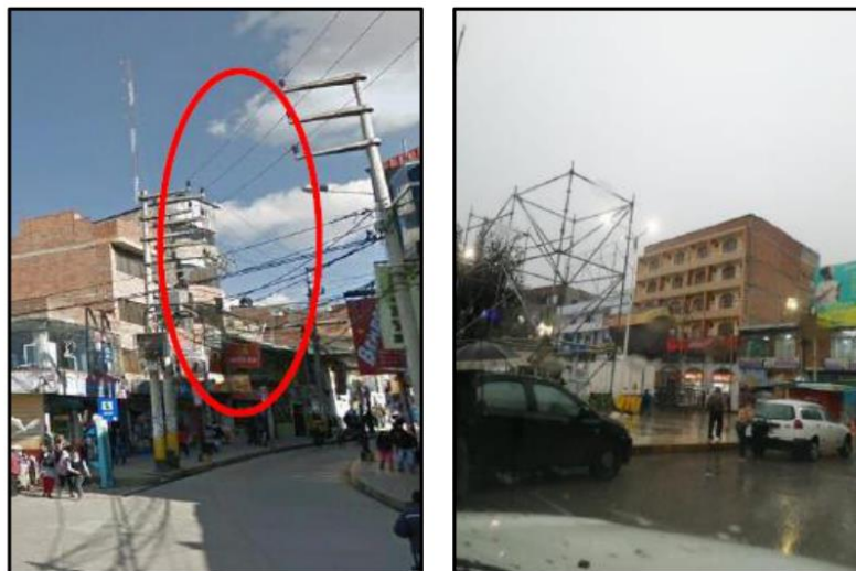
Fig. N° 06: Incumplimiento de las distancias mínimas de seguridad
