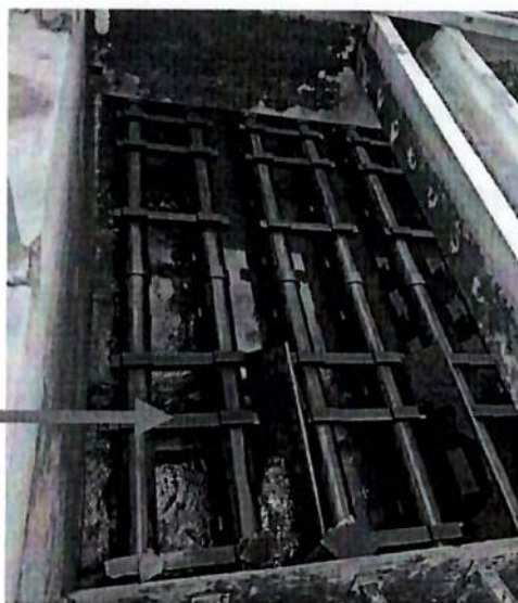
FIG. N° 02 – C: Soporte móviles de concreto, soporte de Planchas Tranquilizadora. Cada fila de 02 tubos, comprende 07 unidades de soporte móvil.
