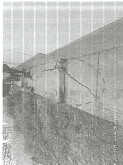
Fotografía N° 6. Las paredes están agrietadas
