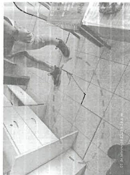
Fotografía N° 2. Piso de cerámico agrietado, pudiendo causar caídas.
