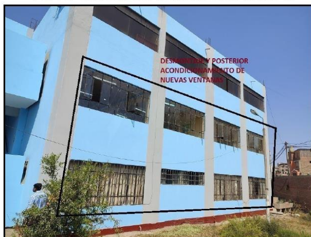
FOTO N° 02: Acondicionamiento de ventanas en el 2do piso.
