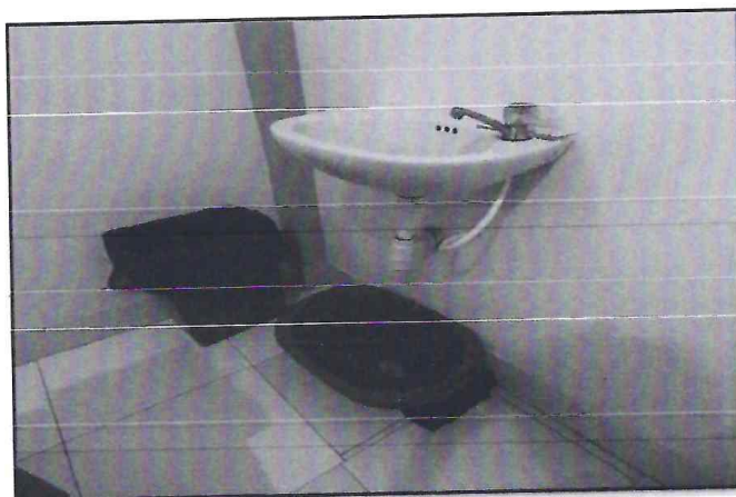
FOTO N°10 - 03/07/2023: Se constata el mal funcionamiento y deterioro de lavatorios .
