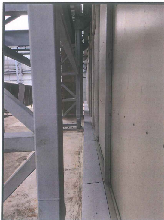
Figura 18. Se verifica que hay espacio y se puede colocar un brazo metálico para no tocar las columnas de concreto ZONA OESTE
