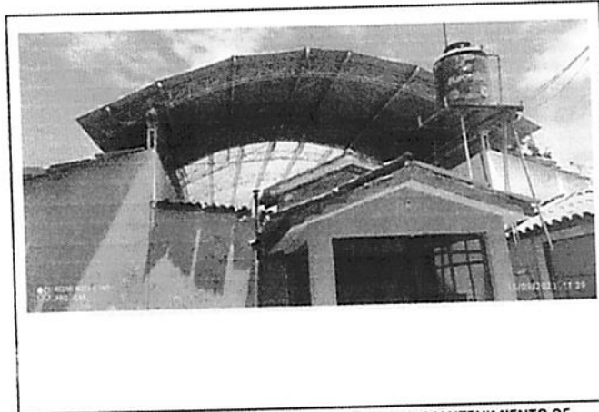
FOTO 04: SE OBSERVA DETERIORO DE TEJA ANDINA, MANTENIMIENTO DE ESTRUCTURA METALICA Y COBERTURA DE ETERNIT Y POLICARBONATO
