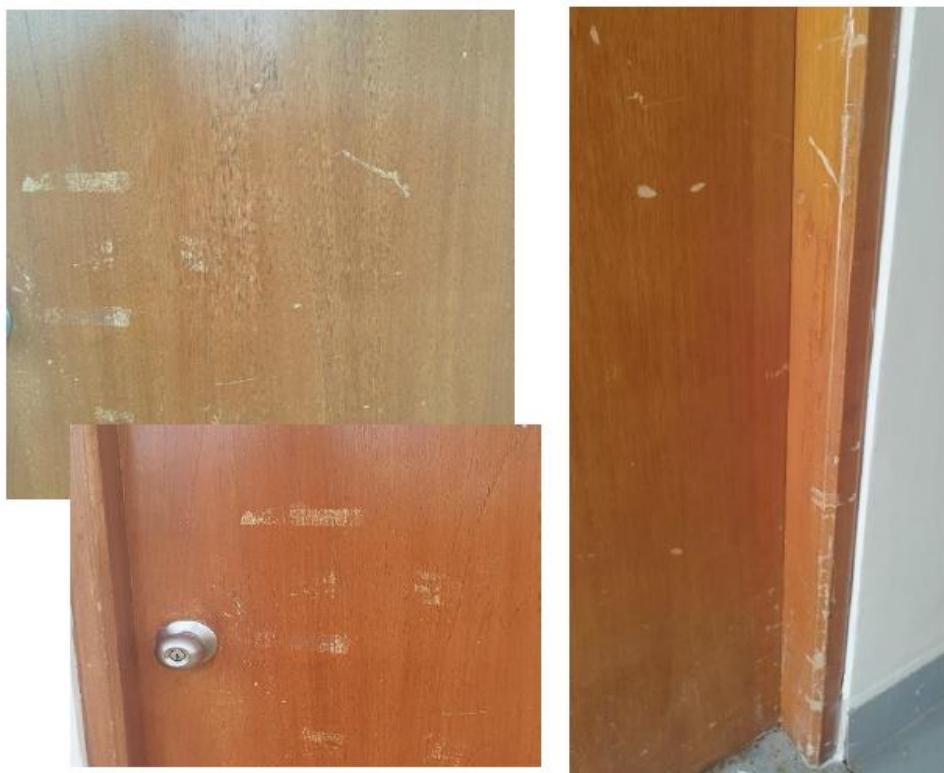
Foto N°6: Imagen referencial del estado situacional de las puertas y marcos de puerta interiores y exteriores de los ambientes ocupados por el NCPP
