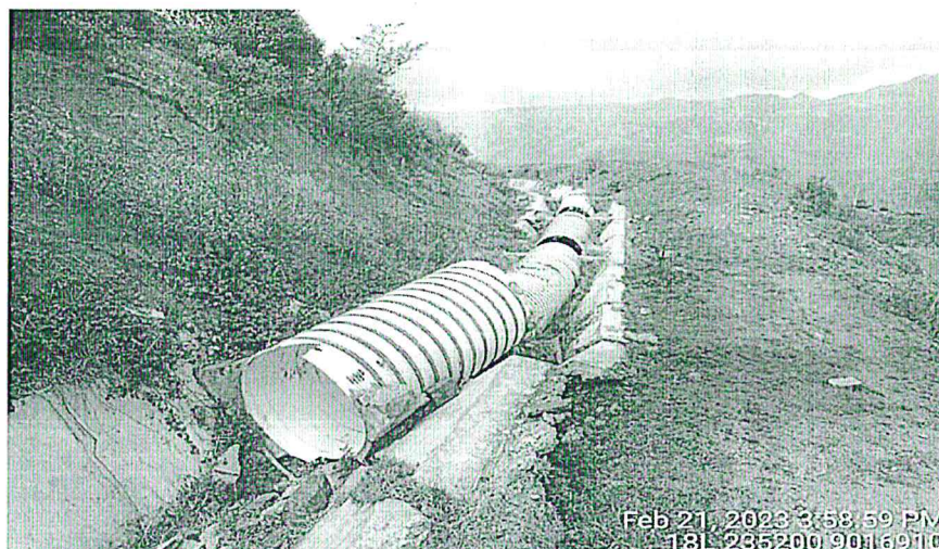
Figura N°13: Movimiento de suelo 04 (L=200m) Se aprecia daños significativos del canal por movimiento de suelo. (Coordenada: 18L-235200 - 9016910)
