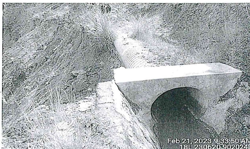
Figura N°05: Talud 01(L=70.00m) En la imagen se aprecia el desprendimiento del talud deja expuesta a la tubería. (Coordenadas: 230620.00 m E, 9020243.00 m S., Zona 18L)
