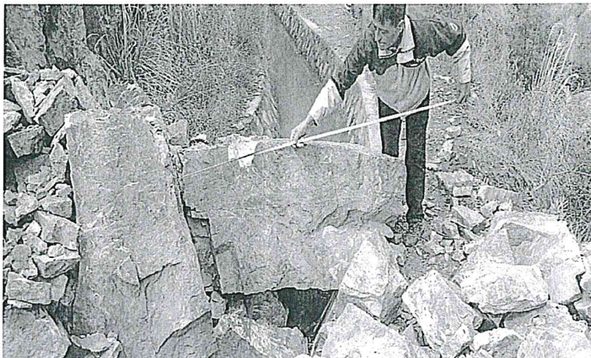
Figura N°11: Movimiento de suelo 02 - ROCA - Desprendimiento de rocas sobre el cauce del canal en una longitud de 50.00 m aprox. (Coordenadas: Latitud 8°51'26.56"S, Longitud 77°27'6.86"O)
