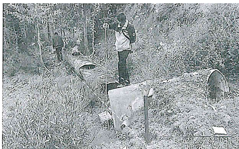
Figura N°06: Talud 02 (L=140m): Se aprecia que el tramo ha descendido aproximadamente 1.20m desde su cota de rasante original en una longitud aproximada de 140.00m. (Coordenadas: 18L 235172 – 9016452)
