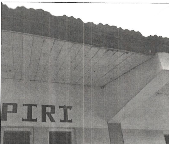
FOTOGRAFIA N° 05: EN LA IMAGEN SE OBSERVA EL DETERIORO DE LAS MADERAS DEL CIELO RASO.
