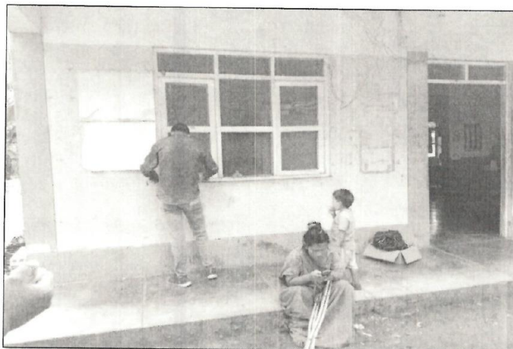
FOTOGRAFIA N° 09: EN LA IMAGEN SE OBSERVA VENTANAS ROTAS, AL CUAL SE PROPONE SU REPOSICION.
