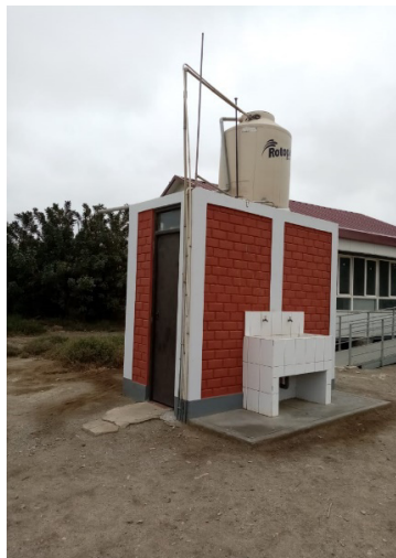
Fotografía 04: Se muestra la conservación de los SS.HH., encima el tanque de agua que se ha implementado para el almacenamiento del agua.
