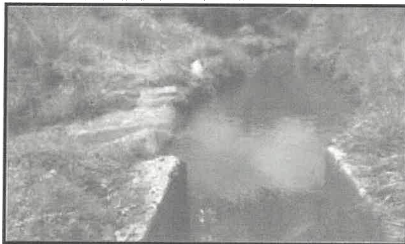
Imagen N° 04: Canal Cascapampa - tramos erosionados
