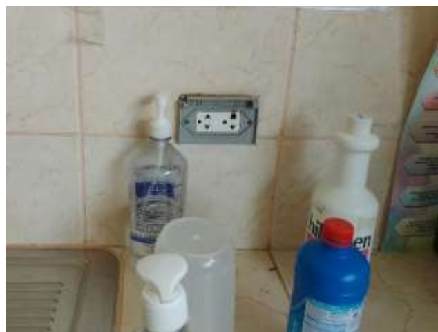
Vista que detalla, toma corriente dañado. Se plantea su cambio. Ambiente de Tópico
