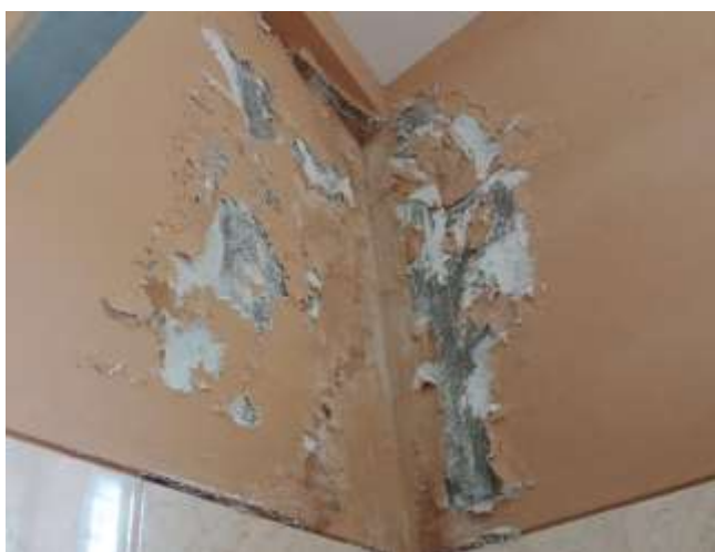
Vista del proceso de exfoliación de la pintura, causado por la humedad. Se plantea el repintado. Pared baño para pacientes-2do corredor transversal
