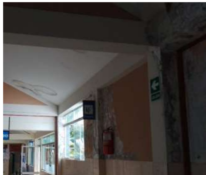
Vista de la exfoliación de la pintura causado por la humedad. Se plantea repintado. 1er corredor longitudinal.
