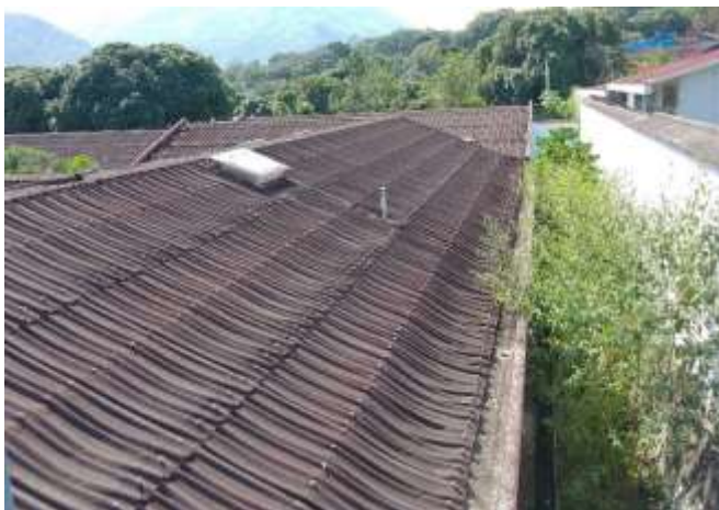
Vista panorámica donde se aprecia la falla generalizada de la cobertura. Se plantea su cambio total. Bloque de consultorios
