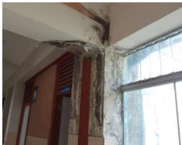
Vista de manchas y exfoliación de la pintura, ocasionado por paso del tiempo. Se planeta repintado. Ambiente internamiento de Obstetricia
