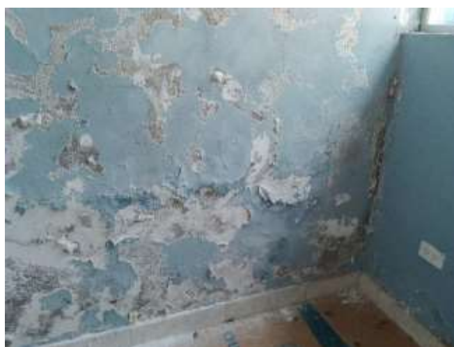
Vista del proceso de exfoliación de la pintura causado por la humedad. Se plantea repintado. Ambiente almacén central- interior.
