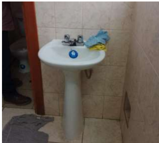
Vista de grifo de lava mano dañado con goteras. Se plantea su cambio. Ambiente internamiento baño de varones
