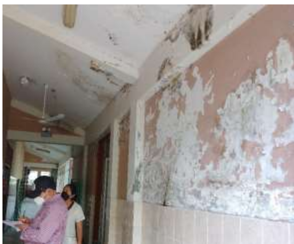
Vista de las manchas y exfoliación de las capas de pintura, usado por la humedad. Se plantea limpieza y repintado. 2do corredor longitudinal
