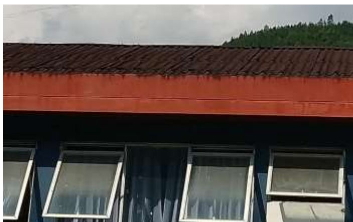
Vista que detalla deformaciones irreversibles de la cobertura. Se planeta cambio de la cobertura.
