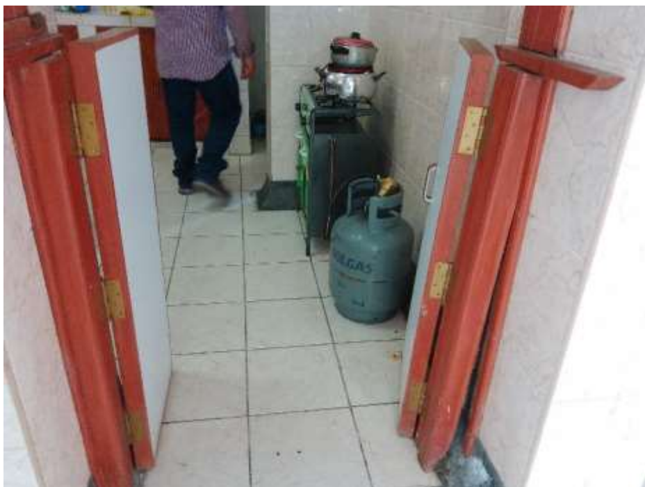
Vista de la puerta con deficiencias en el marco. Se plantea Cambio
