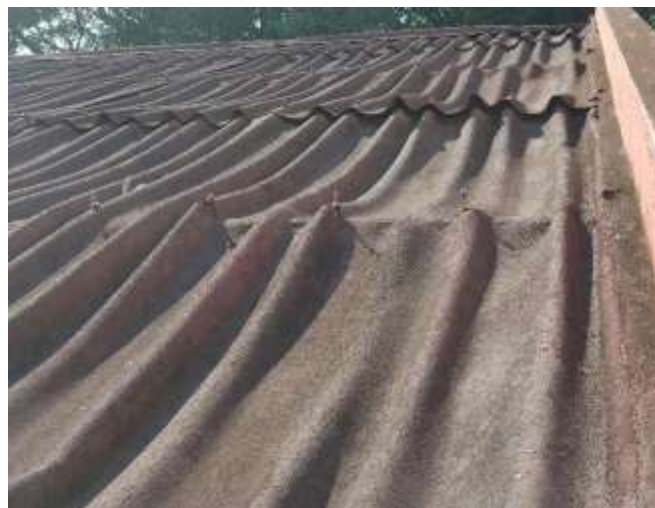
Vista que detalla deformaciones irreversibles de la cobertura. Se planeta cambio de la cobertura. Bloque del almacén central
