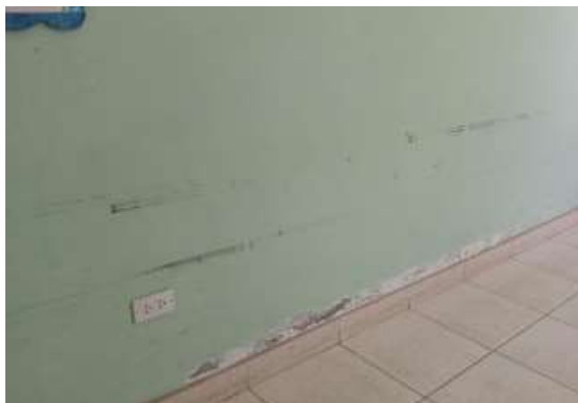
Vista que detalla la exfoliación de la pintura sobre el zócalo, causado por la humedad. Se plantea pintado. Consultorio de medicina.
