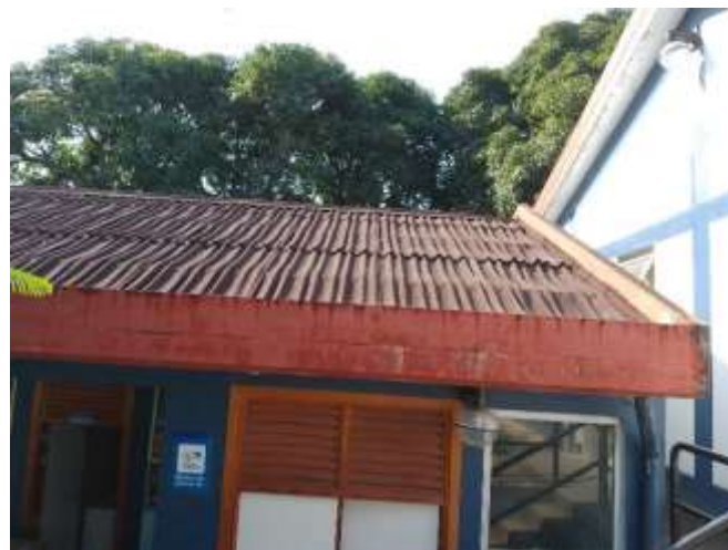
Vista donde se aprecia la falla generalizada de la cobertura. Bloque del almacén central
