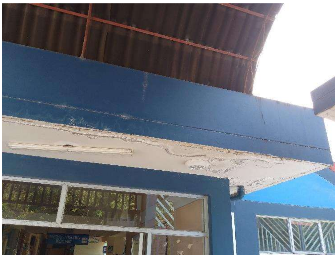
Vista de fisuras y exfoliación de las capas de pintura, alero de la facha principal. Se plantea repintado
