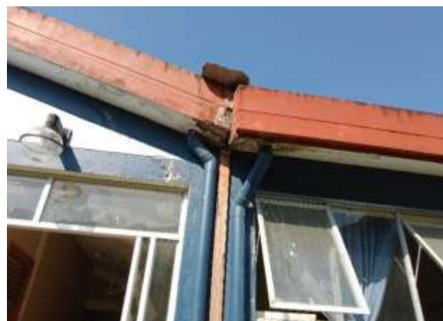
Vista que detalla filtración en la canaleta de concreto que ocasiona la exfoliación de la pintura. Se plantea repintado
