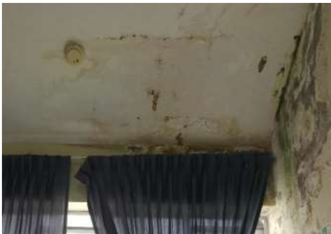
Vista de las manchas y exfoliación del cielo raso. Se plantea limpieza y repintado. Ambiente CRED
