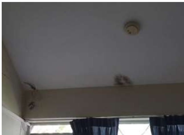
Vista de manchas y exfoliación en el cielo raso, causado por la humedad. Se planeta repintado. Ambiente Dirección
