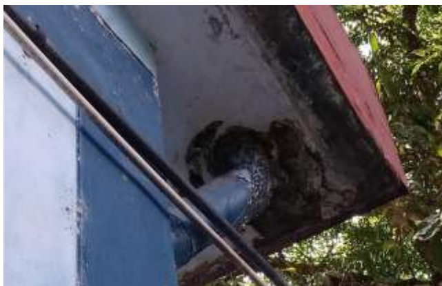
Vista donde se aprecia filtración de la canaleta de concreto que causa exfoliación de la pintura. Se plantea tarrajeo con impermeabilizante y repintado.
