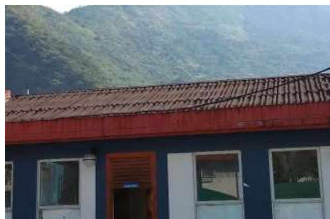
Vista que detalla deformaciones irreversibles de la cobertura. Se planeta cambio de la cobertura. Residencia de medicina
