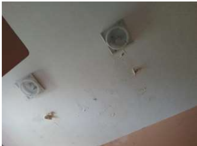
Vista de la exfoliación de la pintura del cielo raso, causado por el paso del tiempo. Baño para uso de pacientes- 2do corredor transversal.
