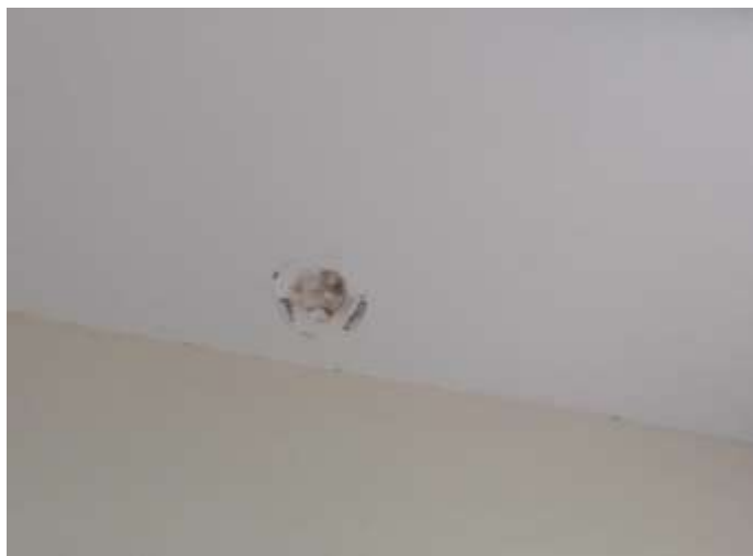
Vista donde se parecía mancha en el cielo raso, ocasionado por la humedad. Se plantea repintado- ambiente tóxico
