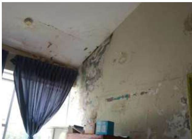
Vistas de las manchas y moho, causado por la presencia de la humedad. Se plantea repintado. Ambiente CRED
