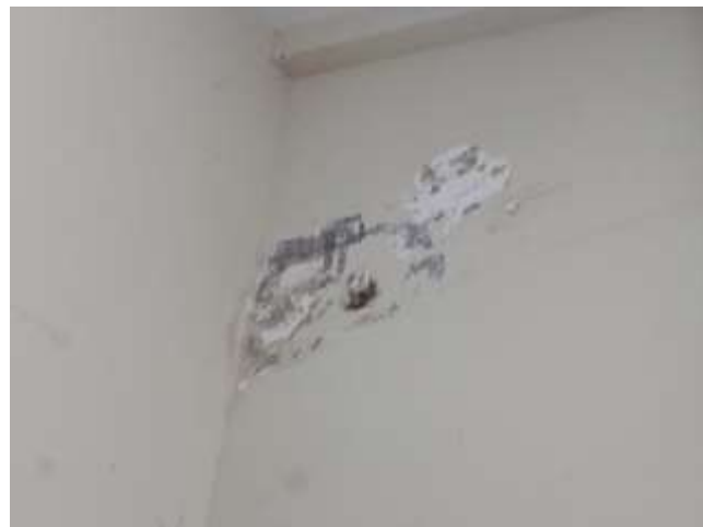
Vista del agujero y exfoliación de las capas de pintura, causado por la humedad y gotera. Se plantea resane y repintado. Ambiente Nutrición
