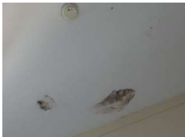
Vista de manchas con moho en el cielo raso, causado por la humedad. Se planeta repintado. Ambiente Admisión
