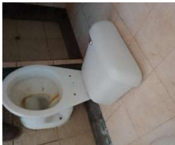
Vista del inodoro con óxidos, causados por el mal funcionamiento se plantea cambio de accesorio. Residencia
