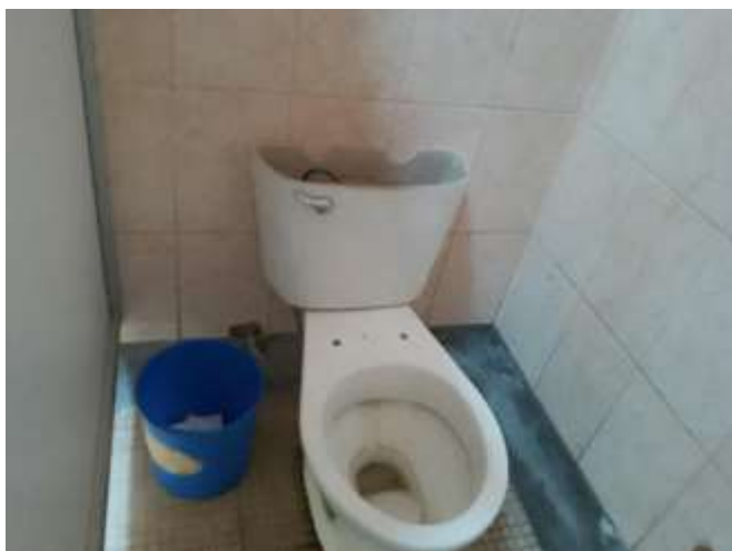
Vista donde se aprecia la ausencia de la tapa del tanque de inodoro. Se plantea reposición. Baño de uso para pacientes
