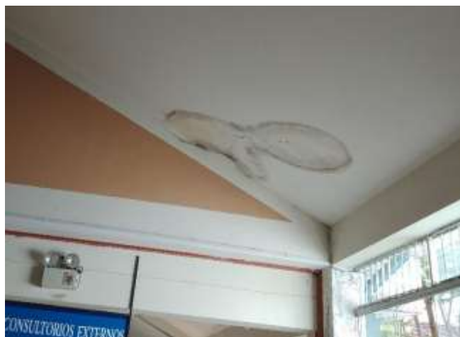
Vista donde se observa manchas en el cielo raso, causadas por la húmeda Se plantea repintado. 1er corredor longitudinal
