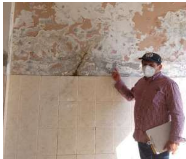
En la vista el consultor realiza la evaluación de las fisuras causadas por la humedad.
