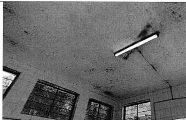
Foto N° 01: Se observa hongos en cielo raso
