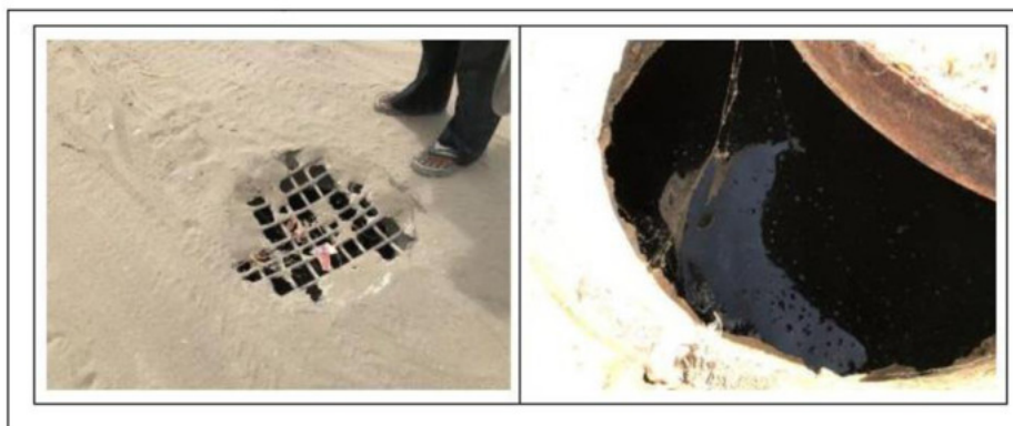
Imagen N° 19 : Buzones con tapas rotas e inundados
