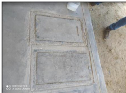
Imagen N°25: Cajas de desagüe con tapa de concreto
