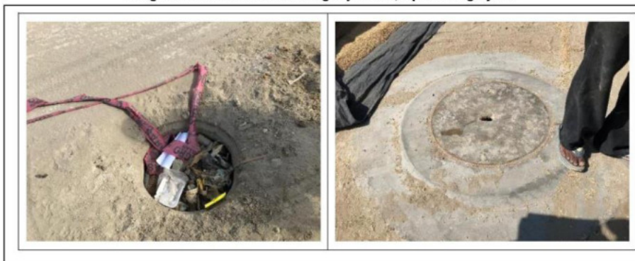
Imagen N°22: Buzones llenos de agua y basura, tapas con agujeros
