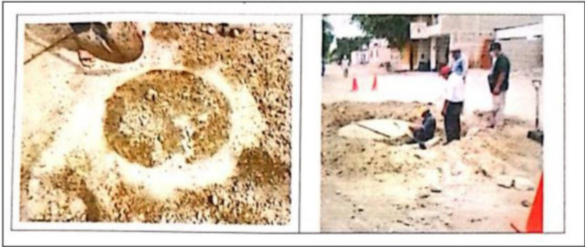
Imagen N°24: Buzones enterrados con tapas en mal estado
