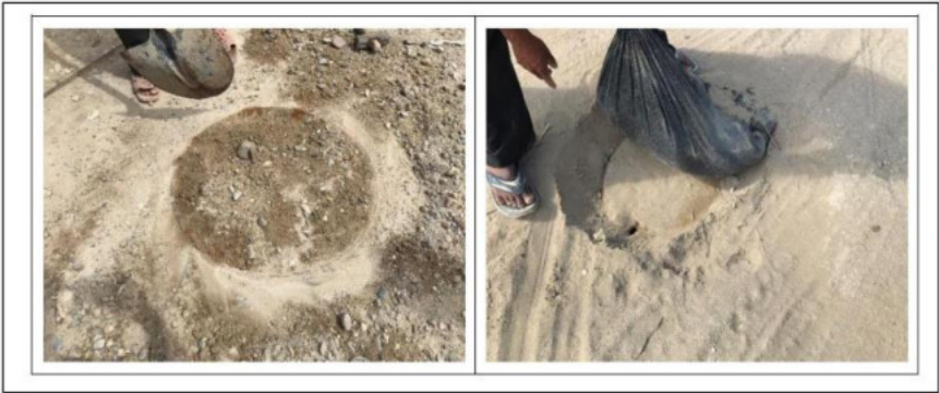
Imagen N°24: Buzones enterrados con tapas en mal estado
