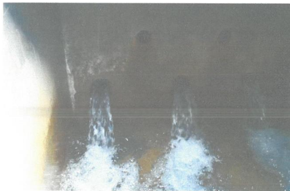
Ilustración N° 05: Vista de interior de la cámara de captación actual, en la que se observa agua con turbiedad. La cámara cuenta con dimensiones de 1.95mx1.95m.
