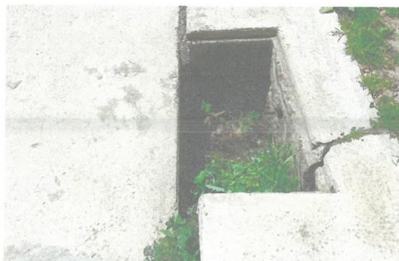
Ilustración N° 09: Vista de la caja de valvulas de control actual de 0.40x0.60m deteriorado.
