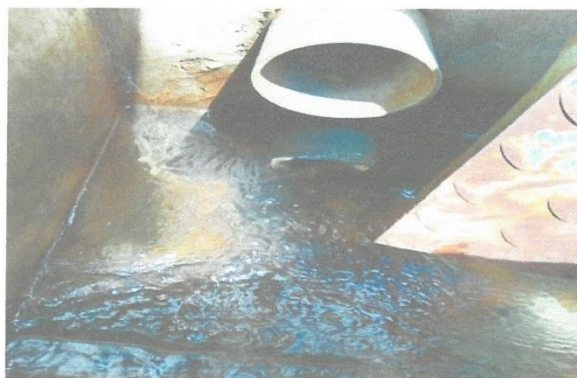
Ilustración N° 06: Vista de la cámara de reunión de 0.60x1.20m deteriorado en la que se observa el agua con alta turbiedad.
