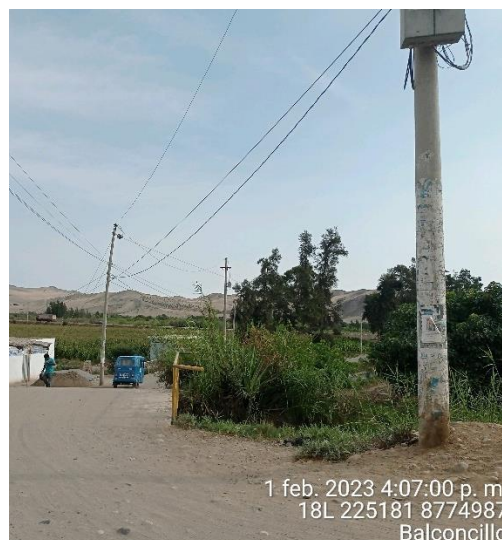
Poste de 12 m, de la MT inclinado
