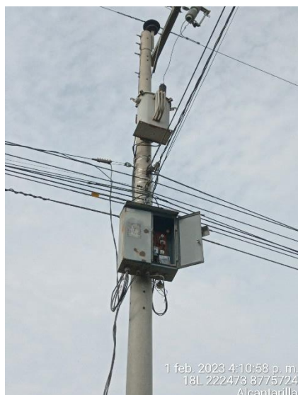
Subestacion de Alcantarilla presenta oxido tanto en el transformador y en el tablero.
