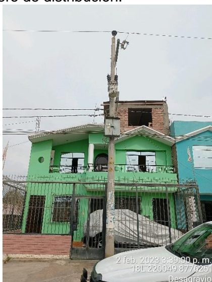
Desagravio, Subestacion quedó en frente de Vivienda incumpliendo las distancias minimas de seguridad, a su vez, la red de MT pasa por encima de vivienda
