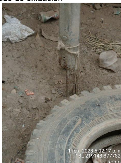
Retenidas de las Redes Secundarias de Rontoy en estado de oxidación.
