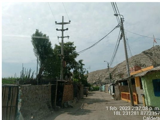
La Caldera, poste de las redes secundarias inclinadas por el esfuerzo del conductor autoportante.
