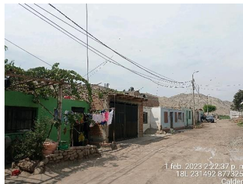
Cable de Red Secundaria incumple DMS respecto a vivienda, por tener vano muy largo.
