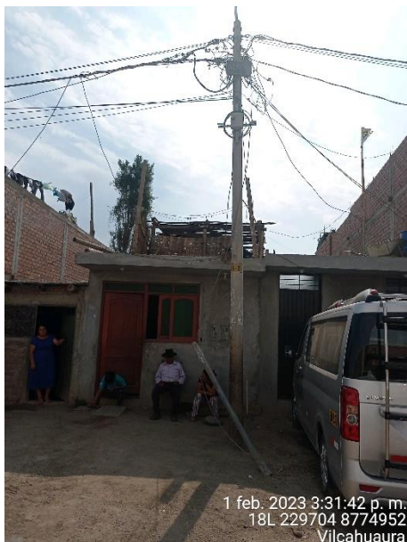
Retenidas de la red secundaria en mal estado, muestra peligro para los transeuntes.
