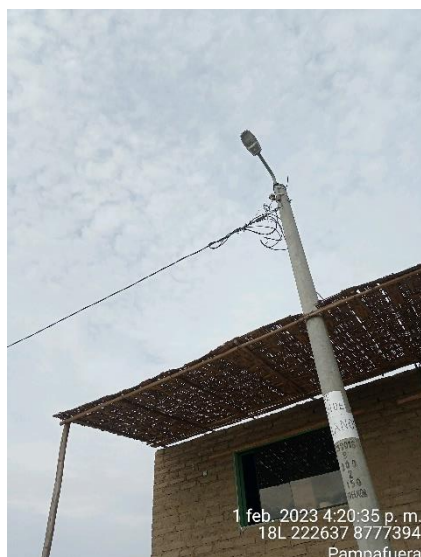
Poste de RS en Pampafuera inclinado a falta de retenida.
