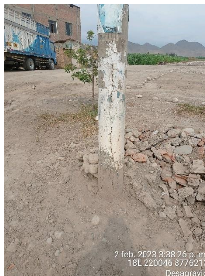
Desagravio, estructuras de esta localidad, muestran grietas en su longitud.
