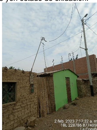
con Tubo de acometida en La Coruña en mal estado.
