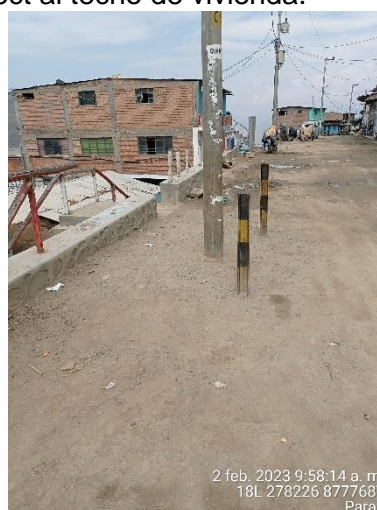
Postes de RS quedaron en medio de la via con peligro a colicion.
