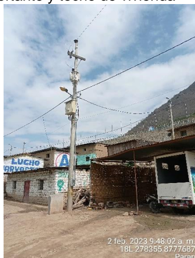
Subestacion de Paran result en frente de cochera, con peligro a ser colicionado
