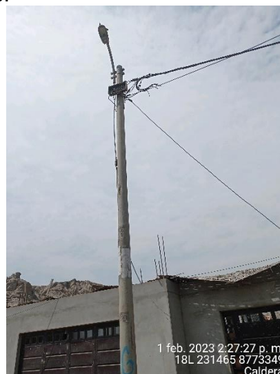
Retenida de RS en mal estado, Caja de derivación sin tapa y en mal estado.
