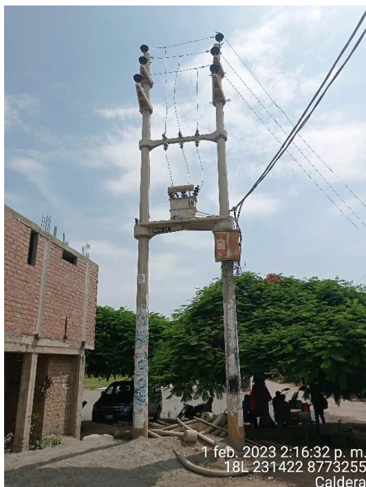
Caldera, SE de esta localidad con presencia de oxido en el tablero de distribución.
