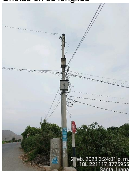
Santa Juana, Subestacion presenta fuga de aceite del transformador, tablero con presencia de óxido.
