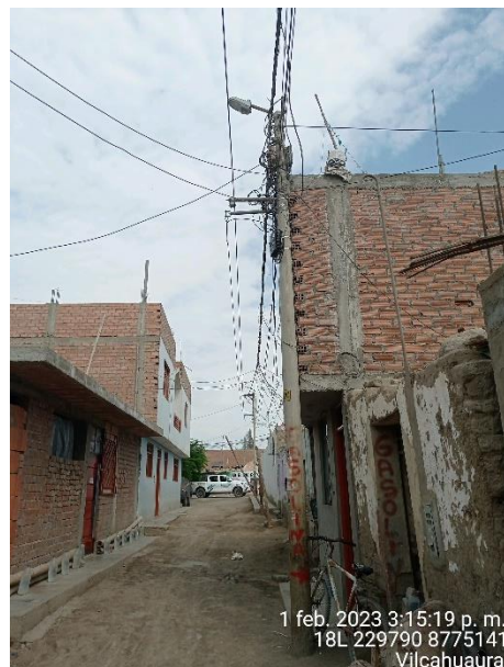
Deficiencias de distancias mínimas de seguridad, se aprecia el paso del conductor Autoportante cerca de la vivienda en la localidad de Vilcahuaura.
