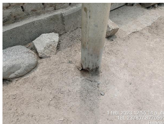
Estructuras de RS de Huacan con presencia de grietas en su base a causa del salitre. En peligro de colapso.
