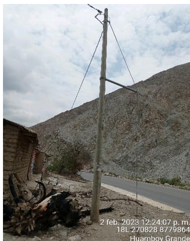
Huamboy Grande, Retenida en RS en mal estado.
