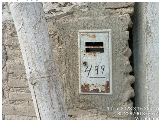
Vilcahuaura, Cajas portamedidor en estado de ooxido en dun 85% del total
