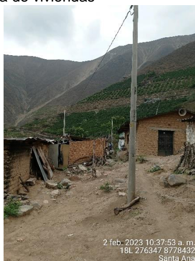
Santa Ana, Conductor autoportante pasa en medio de las viviendas .
