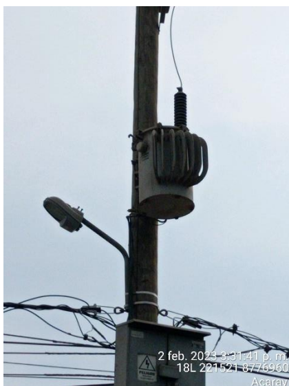
Acaray, Subestacion presenta oxido en el Transformador, como tambien en el Tablero de distribucion.
