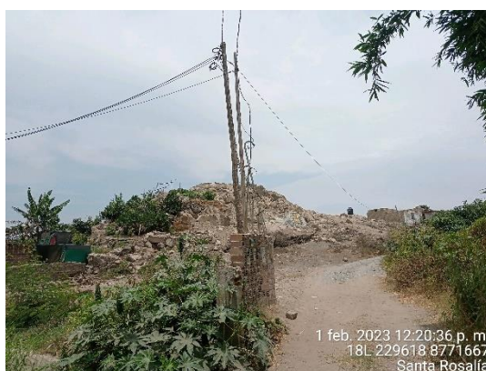
Santa Rosalía, acometidas derivando de poste de madera precario a un banco de medidores.
