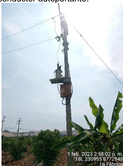
Subestacion de la Fabrica con presencia de oxido en el tablero de distribucion.
