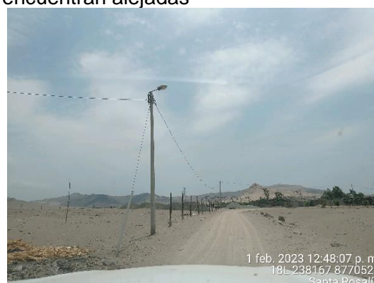
Vano de la Red Secundaria en Santa Rosalía muy distante, haciendo que el conductor autoportante incumpla DMS respecto al nivel del terreno.
