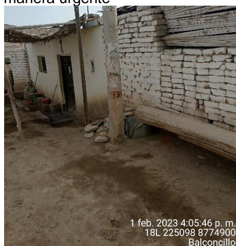
Balconcillo, poste de RS en mal estado presenta grietas en su base a causa del salitre.
