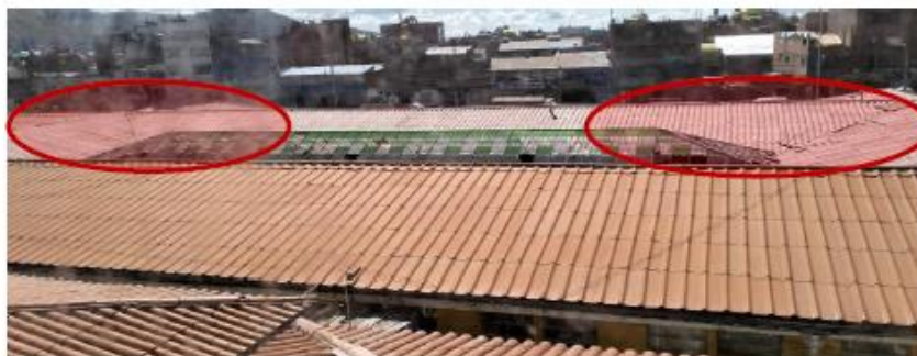
Imagen 03: teja Residencial, se encuentran mal colocadas, deterioradas
