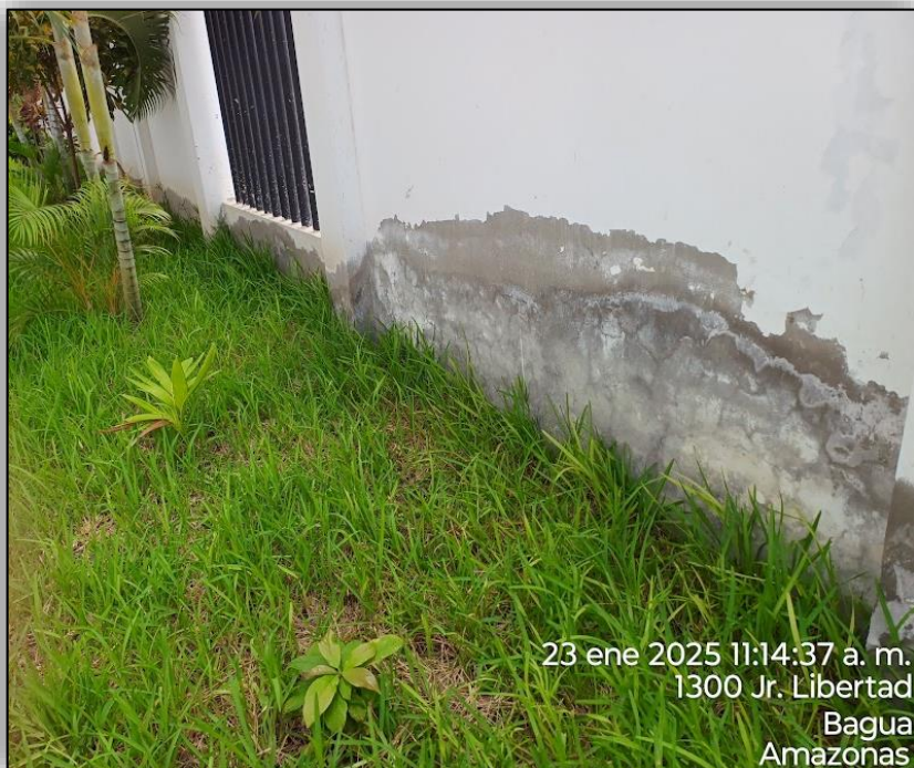
Fotografía 6: vista de desprendimiento de pintura y humedad en tarrajeo del cerco perimétrico.
