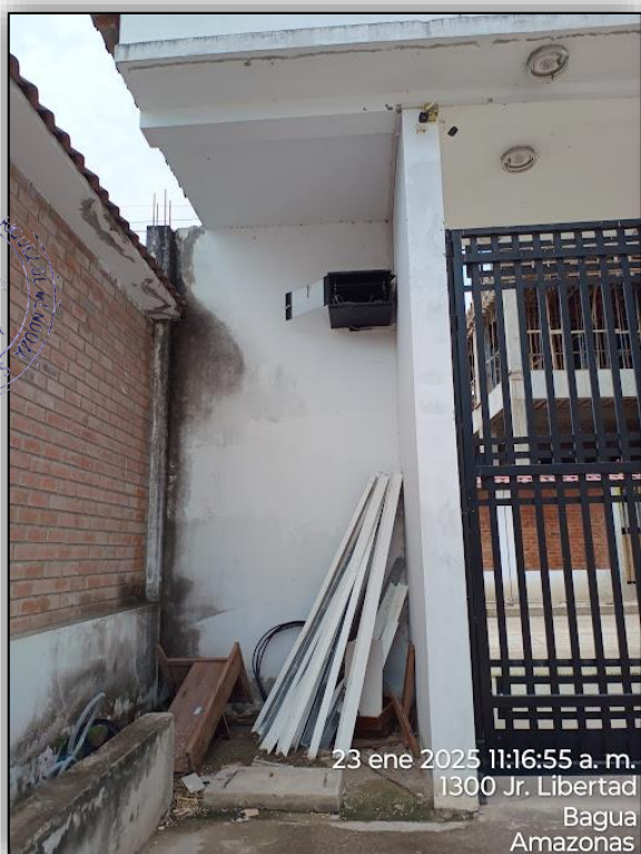
Fotografía 43: vista de presencia de humedad en columnas y paredes.
