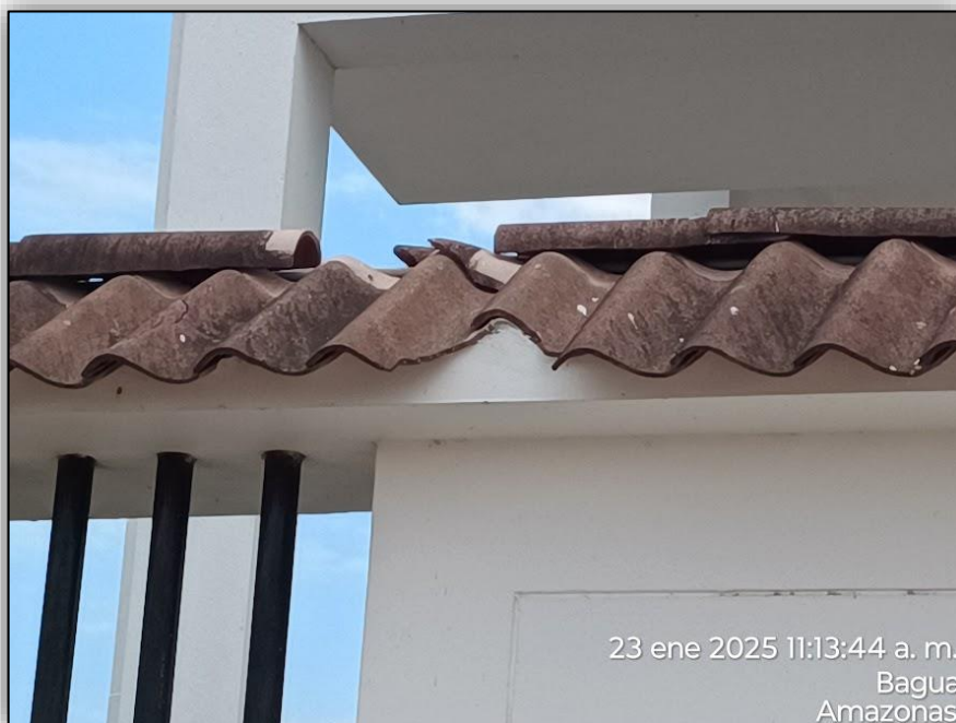
Fotografía 8: se evidencia coberturas deterioradas en cerco perimétrico.
