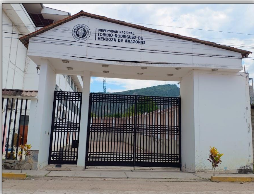
Fotografía 9: se evidencia el avanzado deterioro del pórtico de ingreso vehicular. Losa pandeada, cerramiento de fibrocemento en mal estado de conservación.
