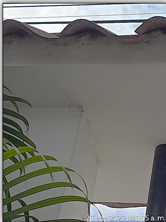
Fotografía 7: se evidencia la falla entre viga y columna.
