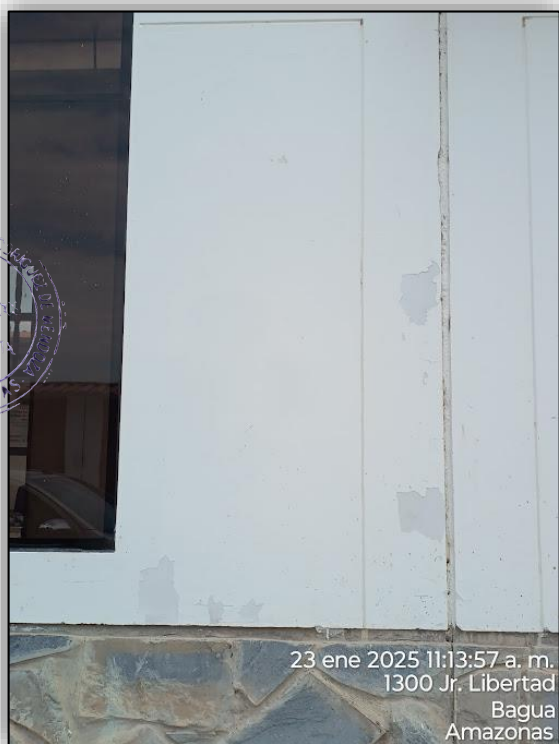
Fotografía 4 y 5: vista de desprendimiento de pintura en caseta de pórtico de ingreso peatonal.
