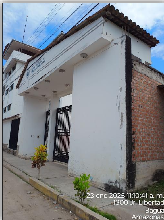
Fotografía 10: vista de pandeo de losa, luminarias defectuosas, muros con presencia de humedad y paredes con desprendimiento de pintura.
