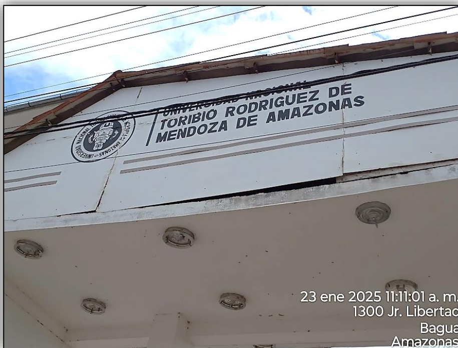
Fotografía 11: se evidencia el deterioro avanzado del cerramiento de fibrocemento del pórtico de ingreso vehicular.
