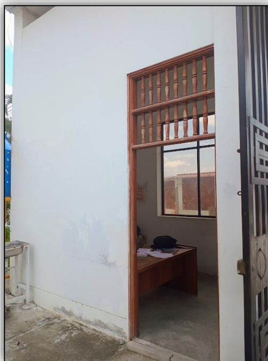
Fotografía 4 y 5: vista de desprendimiento de pintura en caseta de pórtico de ingreso peatonal.
