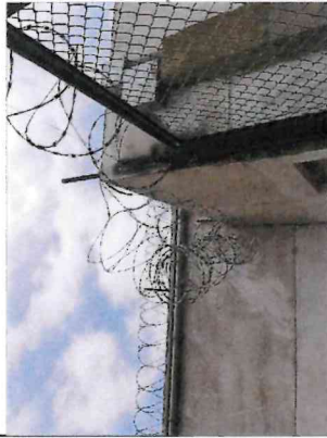
VISTA DE TECHO DE SUB-ESTACIÓN CON CONCERTINAS EN MAL ESTADO CAÍDAS Y DEFORMES
