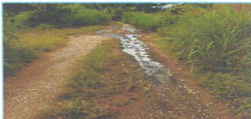
Fotografía N° 06: Cunetas coberturadas de malesas
