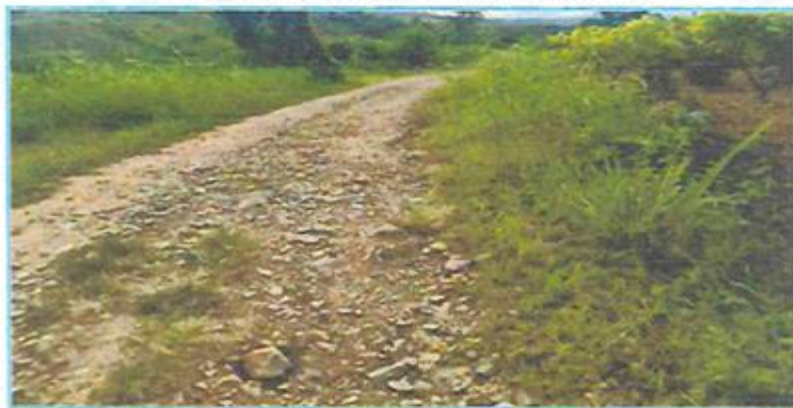
Fotografía N°05: Surcos de erosión en la vía
