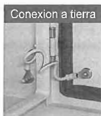
3 pernos electrosoldados (2 interior del cuerpo y 1 en puerta).
