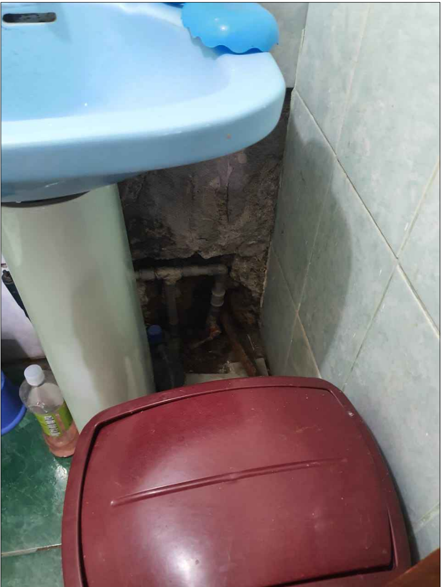
FOTO 03: ZÓCALO DE SERVICIO HIGIÉNICO EN MAL ESTADO
