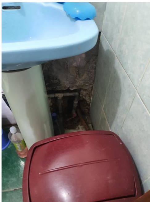
FOTO 08: SE OBSERVA LAVATORIO Y CONTRAZÓCALO DE S.H EN MAL ESTADO
