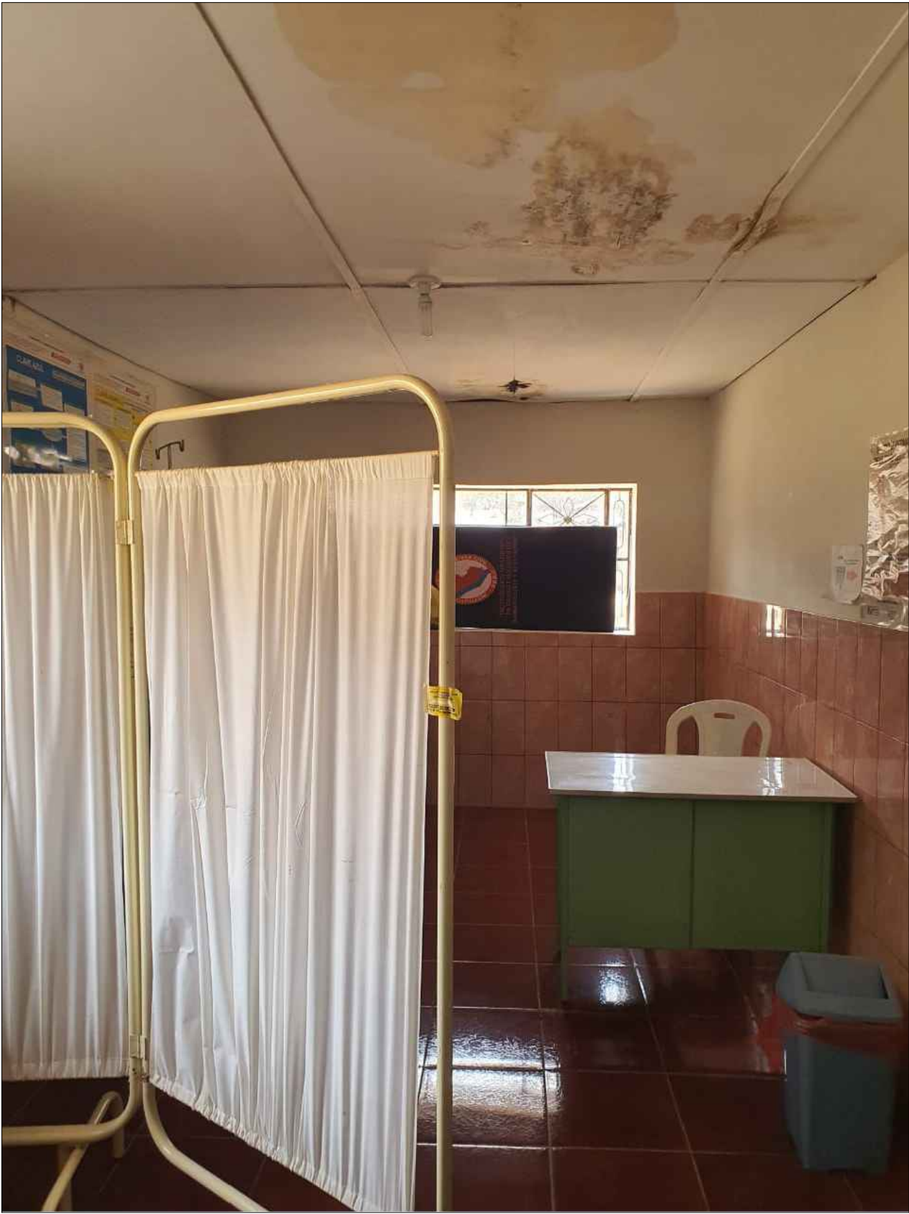
FOTO 02: CIELO RASO EXISTENTE EN MAL ESTADO EN SALA DE PARTOS
