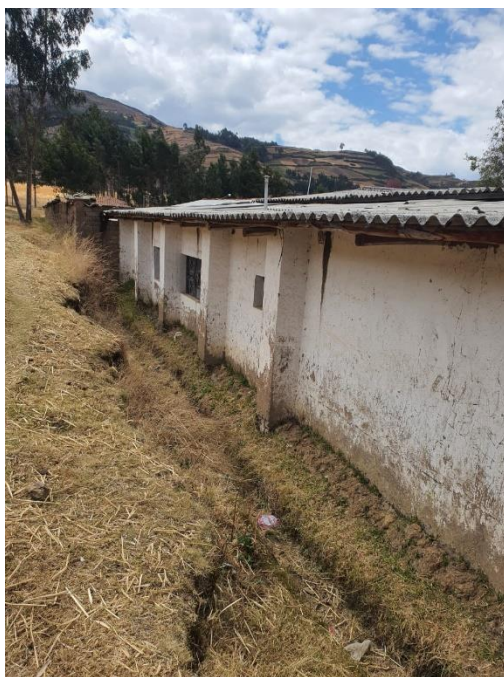
FOTO 03: SE OBSERVA PINTURA EXTERIOR EN MAL ESTADO
