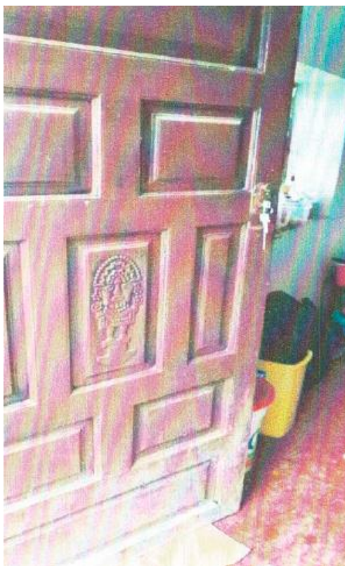
FOTO 07: SE OBSERVA PINTURA DE PUERTA EN MAL ESTADO
