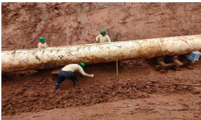
Gráfico 8 Excavación manual para liberar la tubería.
